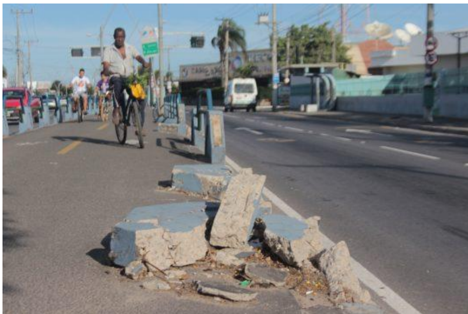
Figura 62 - Manutenção Av. 28 março
