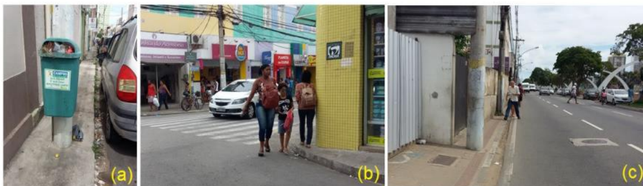
Figura 98 - Calçada estreita com poste e lixeira com calçada estreita e muro avançando sobre a calçada na Zona Centro Histórico de Campos dos Goytacazes, RJ.
