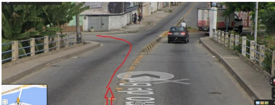
Figura 120 - Descida contramão ponte Saturnino Braga
