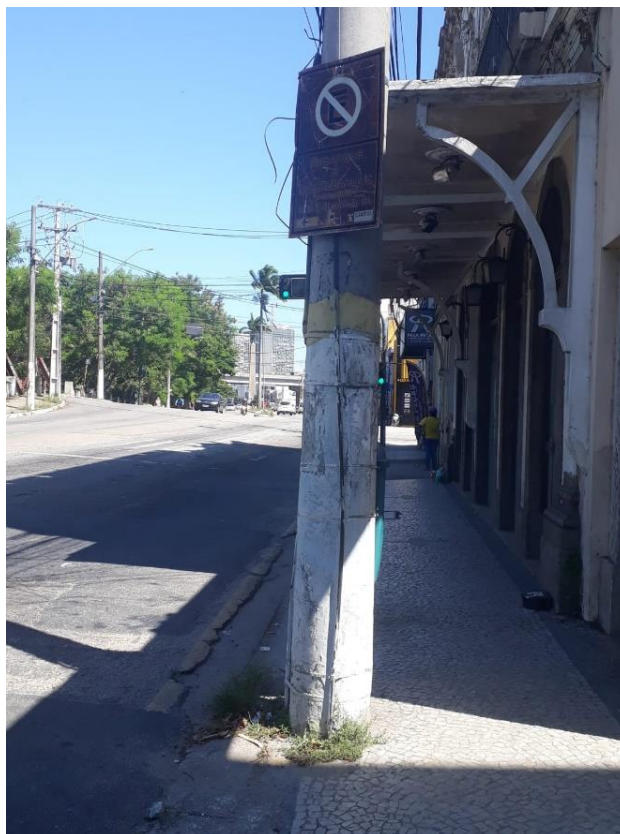
Figura 96 - Situação de precariedade de placa de sinalização - Local Av. XV de Novembro - Frente Palace Hotel
