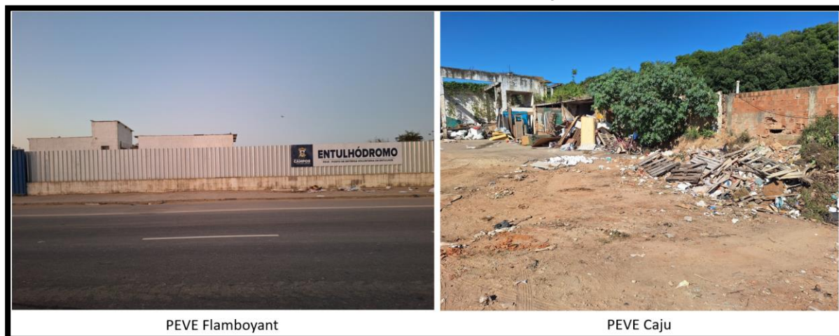
Figura 22 – PEVEs em operação
