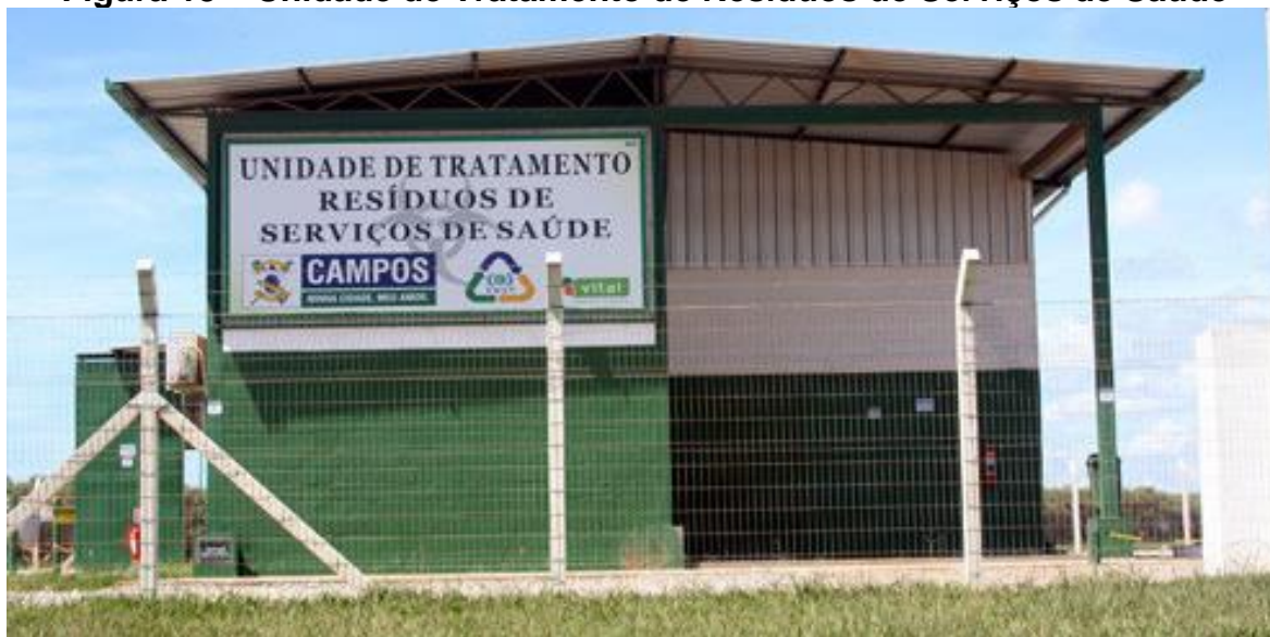
Figura 18 – Unidade de Tratamento de Resíduos de Serviços de Saúde
