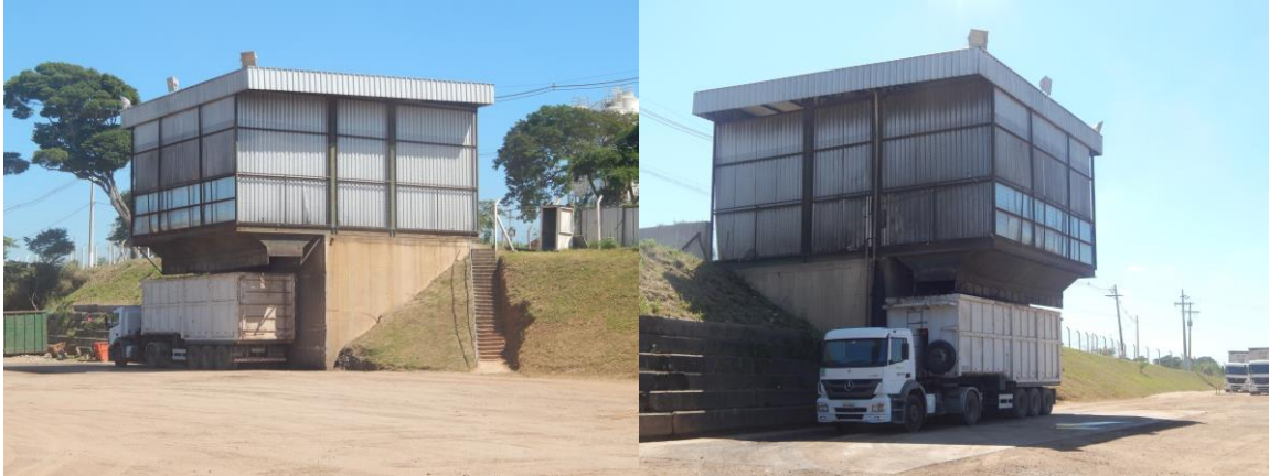
Figura 4 – Estação de transbordo de Campos dos Goytacazes
