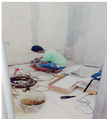
Figura 5.9.7 – Colocação de piso.
