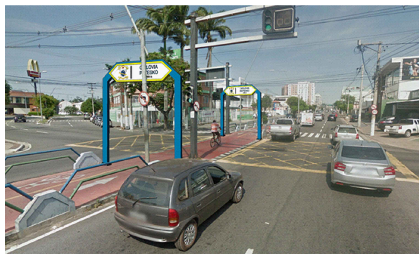
05 INTERVENÇÃO NA AVENIDA 28 DE MARÇO ACESSO À AVENIDA JOSÉ ALVES DE AZEVEDO
