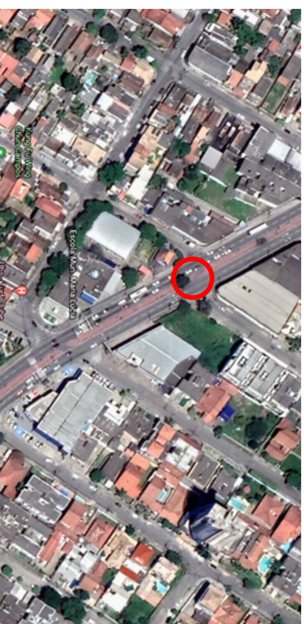
05 INTERVENÇÃO NA AVENIDA 28 DE MARÇO ACESSO À RUA PEDRO MARTINS
