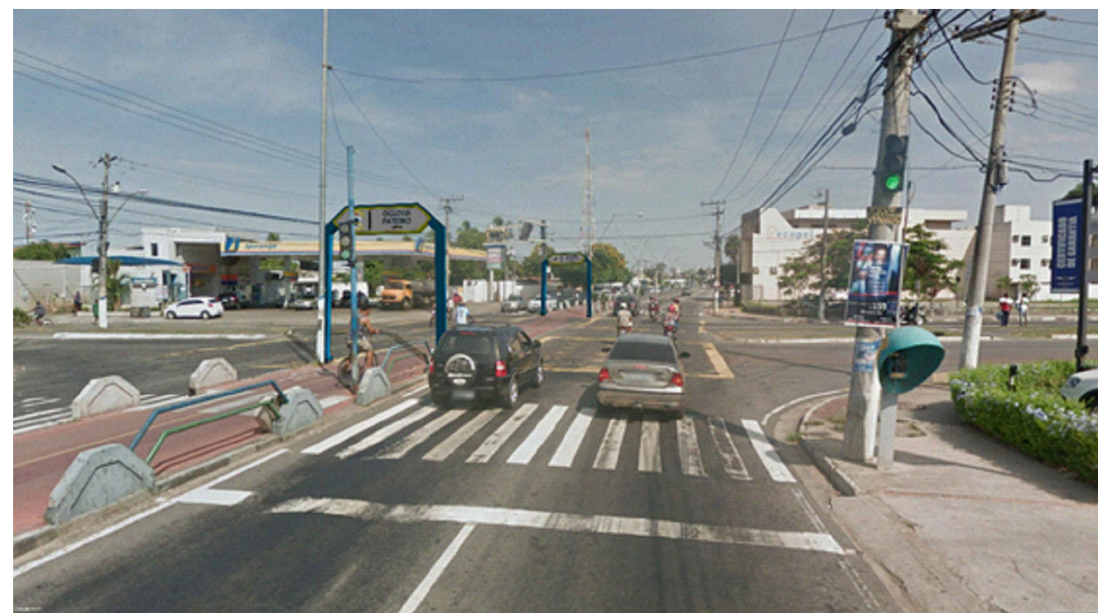
03 INTERVENÇÃO NA AVENIDA 28 DE MARÇO ACESSO À AVENIDA ARTHUR BERNARDES
