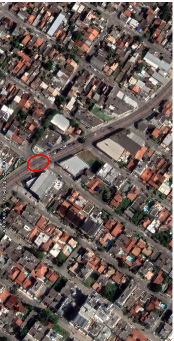
Figura 6: Acesso à Rua Oswaldo Tavares.
