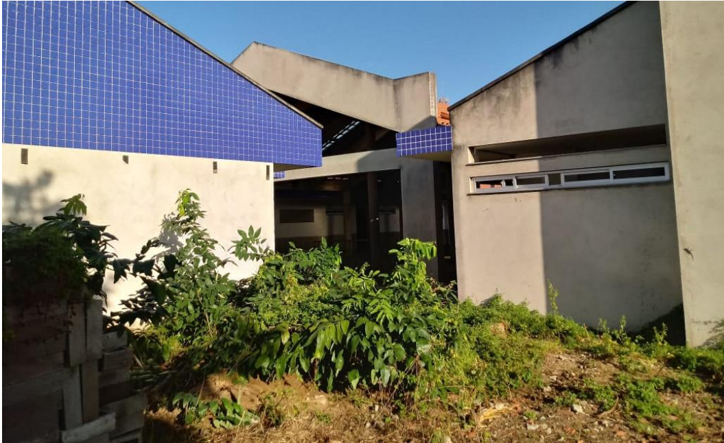
Foto 1 – Capina e repintura externa
