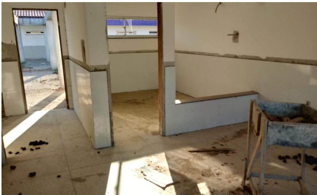
Foto 4 – Área interna da creche
