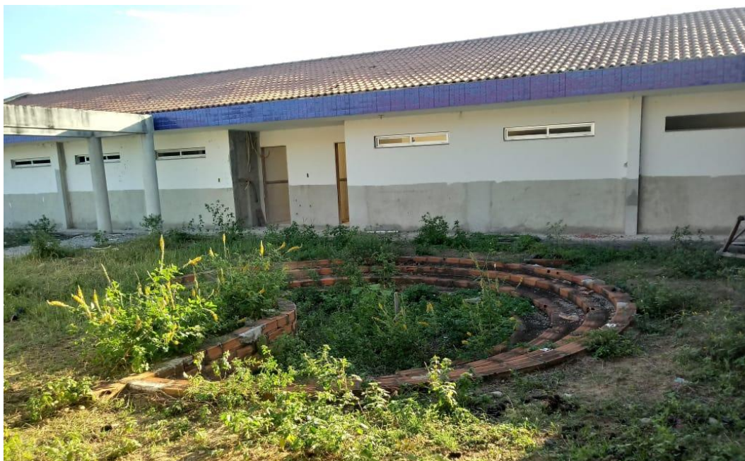
Foto 8 – Capina da área externa
