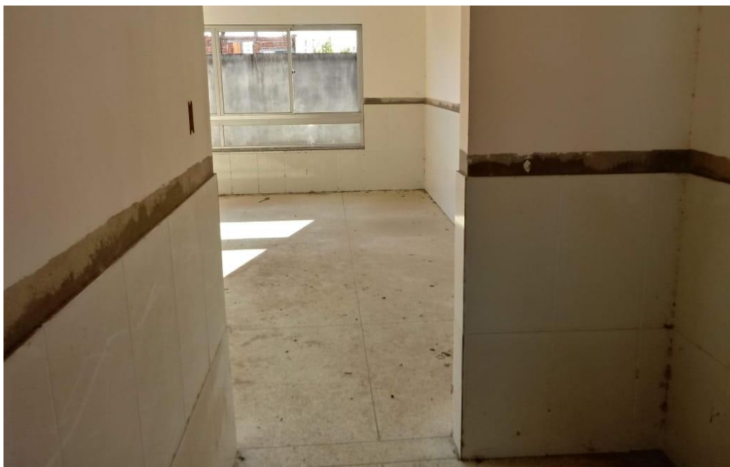
Foto 10 – Instalação do revestimento
