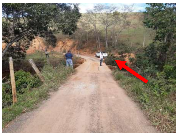
Figura 63 – Proximidade da curva, sem sinalização ou iluminação.
