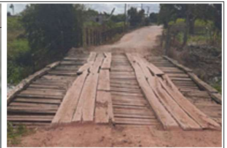
5 IMAGEM DO PONTO DE TRAVESSIA
