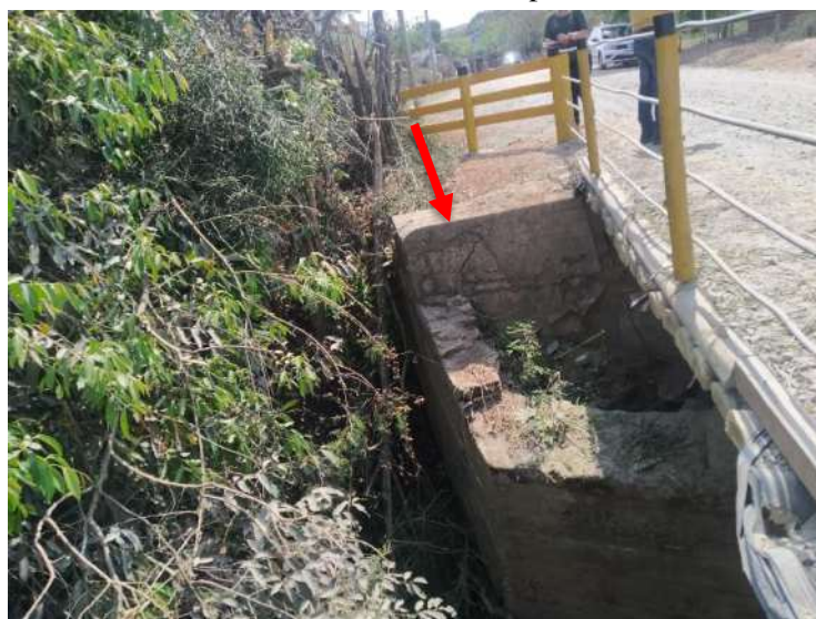
Figura 23 - Encontro com madeiramento de caráter provisório, desordenado e em deterioração.
