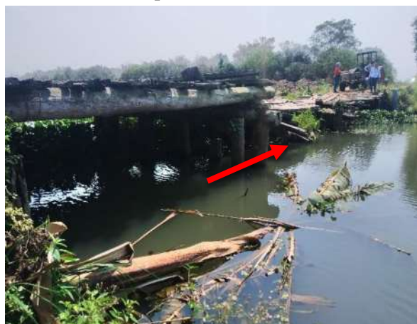
Figura 45 - Foto 11 – Tabuleiro de encontro com o Canal.
