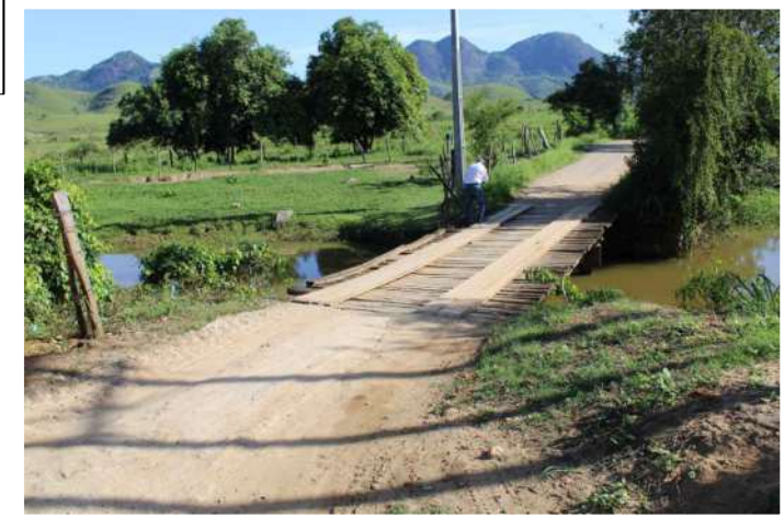
6 IMAGEM DO PONTO DE TRAVESSIA
