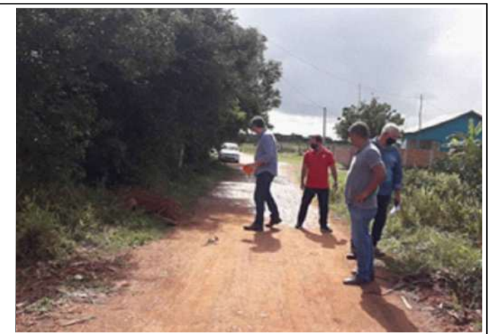
5 IMAGEM DO TRECHO DE TRAVESSIA
