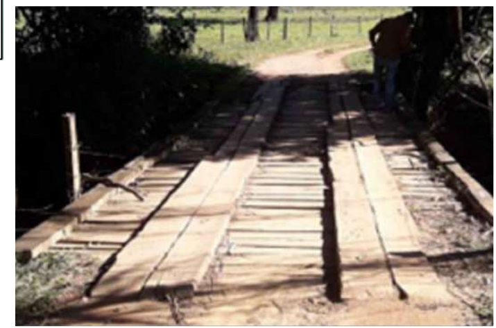
6 IMAGEM DO TRECHO DE TRAVESSIA
