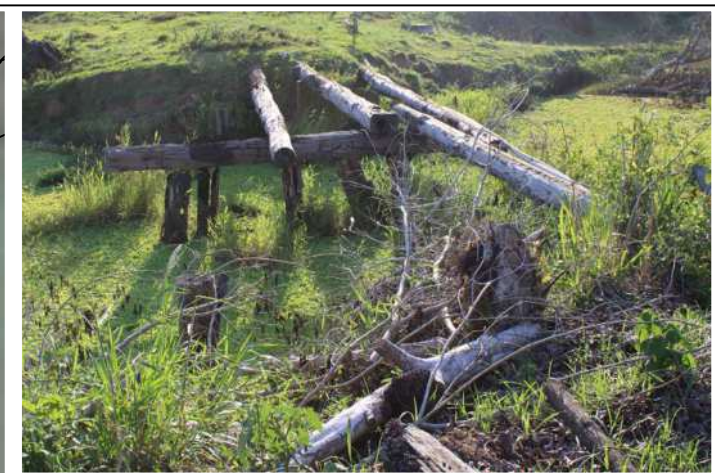
5 IMAGEM DO PONTO DE TRAVESSIA
