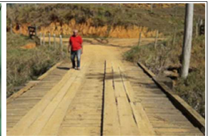
5 IMAGEM DO TRECHO DE TRAVESSIA
