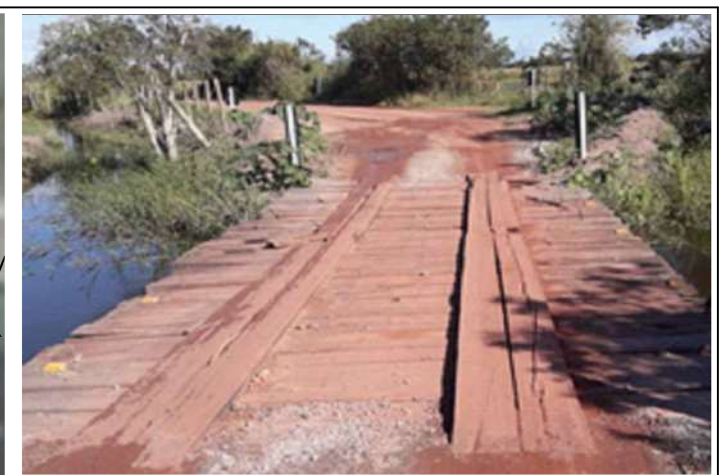
5 IMAGEM DO TRECHO DE TRAVESSIA
