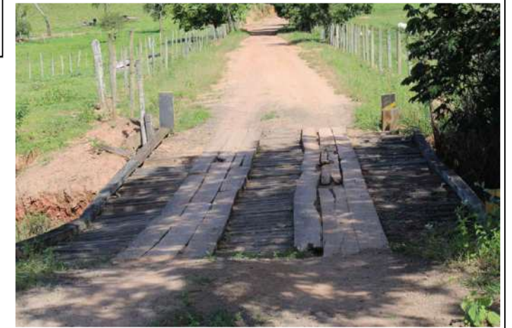
6 IMAGEM DO PONTO DE TRAVESSIA
