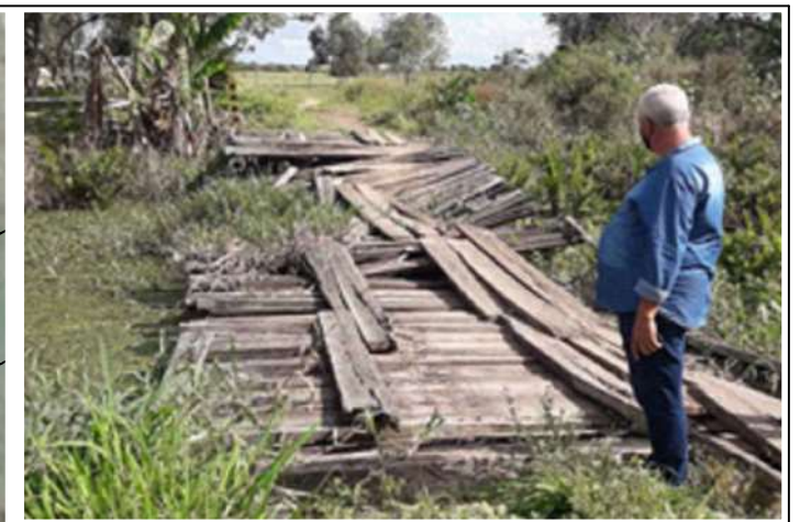
5 IMAGEM DO TRECHO DE TRAVESSIA
