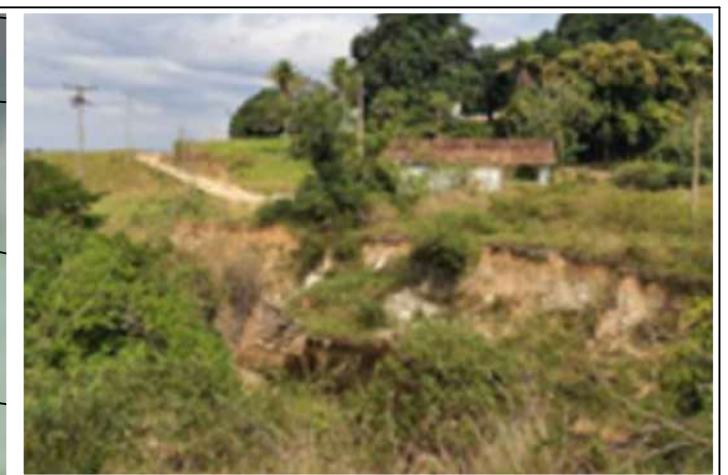
5 IMAGEM DO TRECHO NO PONTO DE TRAVESSIA
