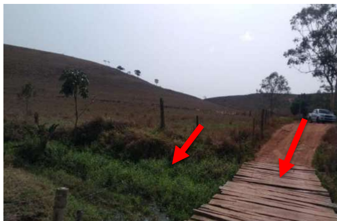
Figura 4 – Vegetação intensa no leito do rio. Peças do tabuleiro soltas.
