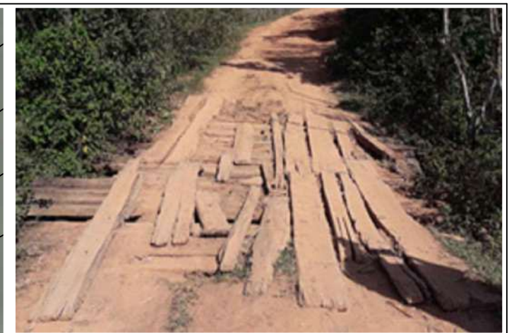
5 IMAGEM DO TRECHO DE TRAVESSIA
