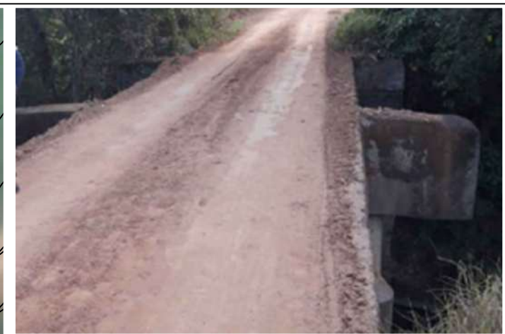
5 IMAGEM DO TRECHO DE TRAVESSIA
