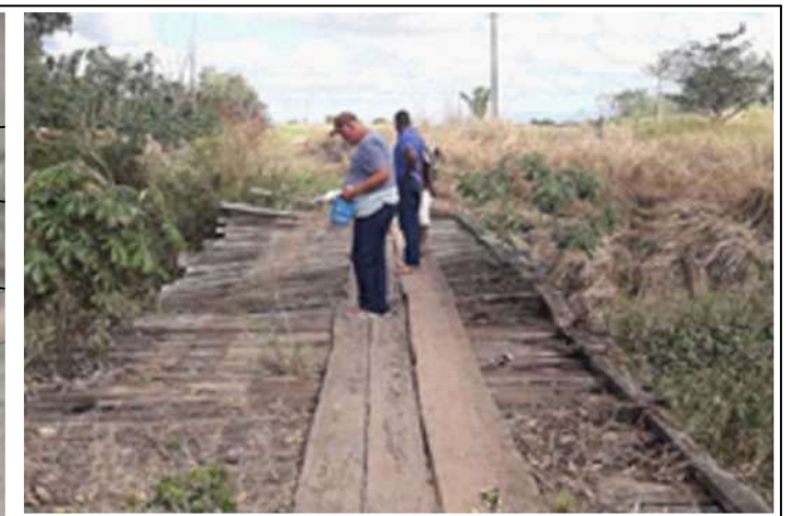
5 IMAGEM DO TRECHO DE TRAVESSIA
