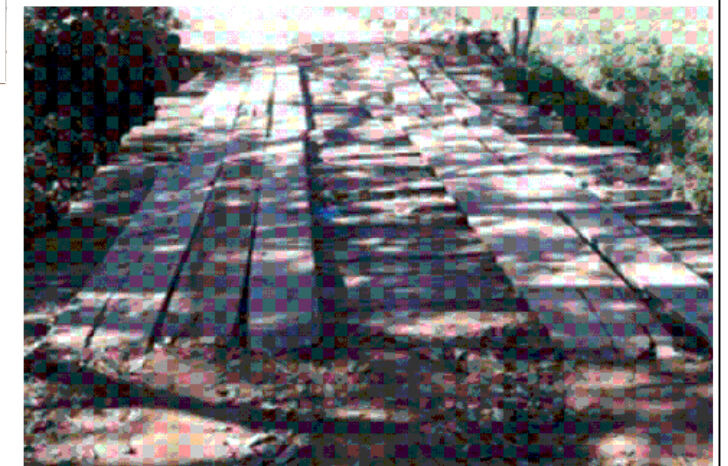
6 IMAGEM DO PONTO DE TRAVESSIA
