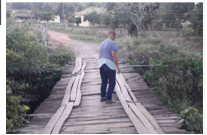
6 IMAGEM DO PONTO DE TRAVESSIA
