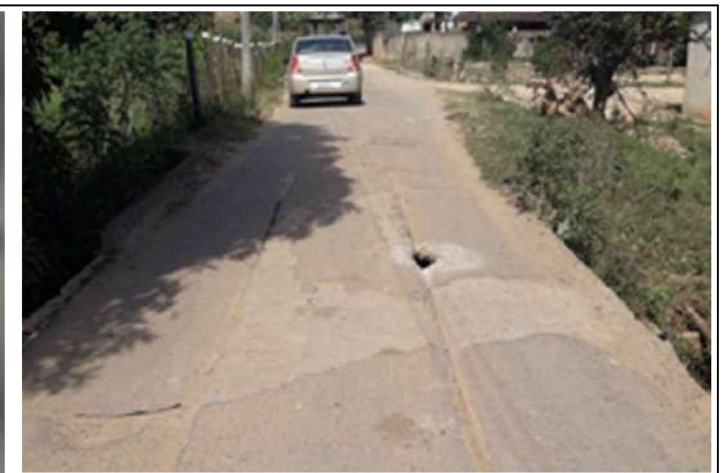
5 IMAGEM DO TRECHO DE TRAVESSIA
