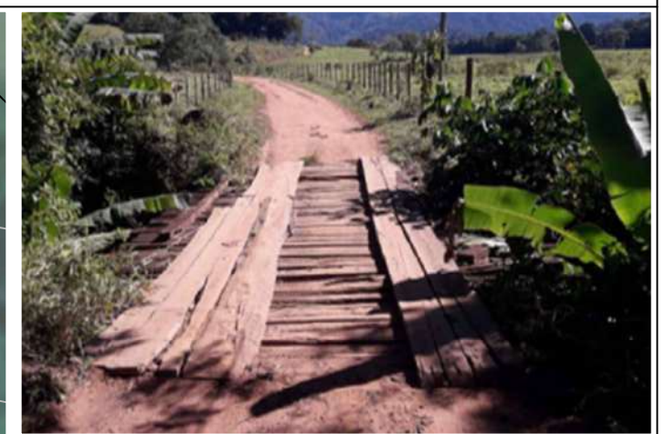
5 IMAGEM DA PONTE NO SENTIDO DA TRAVESSIA
