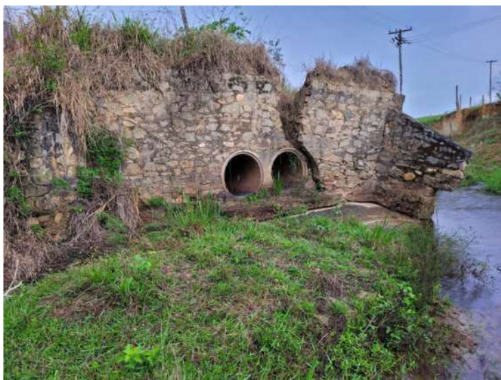
Figura 161: Restos da ponte inexistente atualmente
