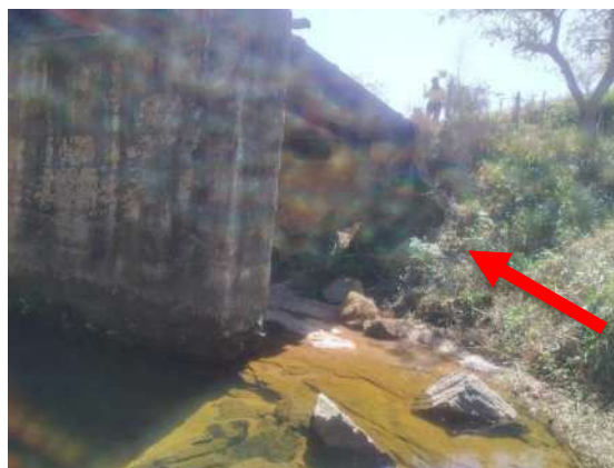
Figura 83 – Vegetação adentrando o talude.
