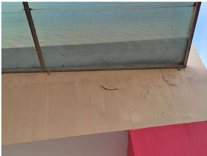
**Foto 15 - Infiltração na parede**
