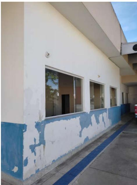
**Foto 17 - Parede Necessitando de pintura**
