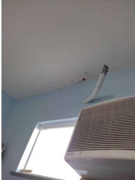
**Foto 11 - Infiltração no teto**
