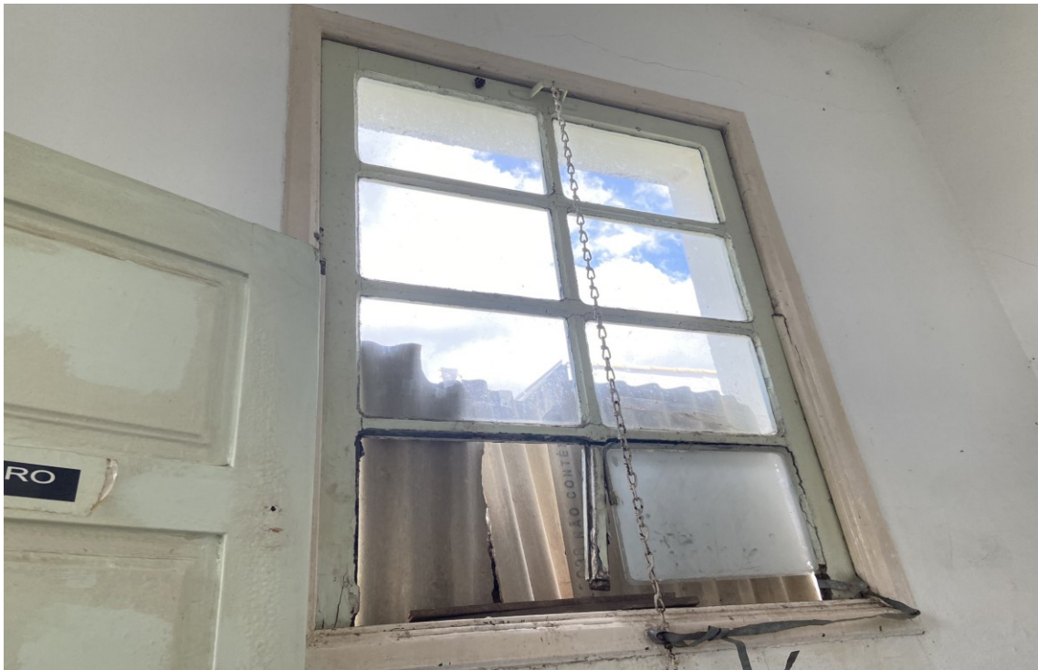
FOTO 26: BANHEIRO DOS FUNCIONÁRIOS
