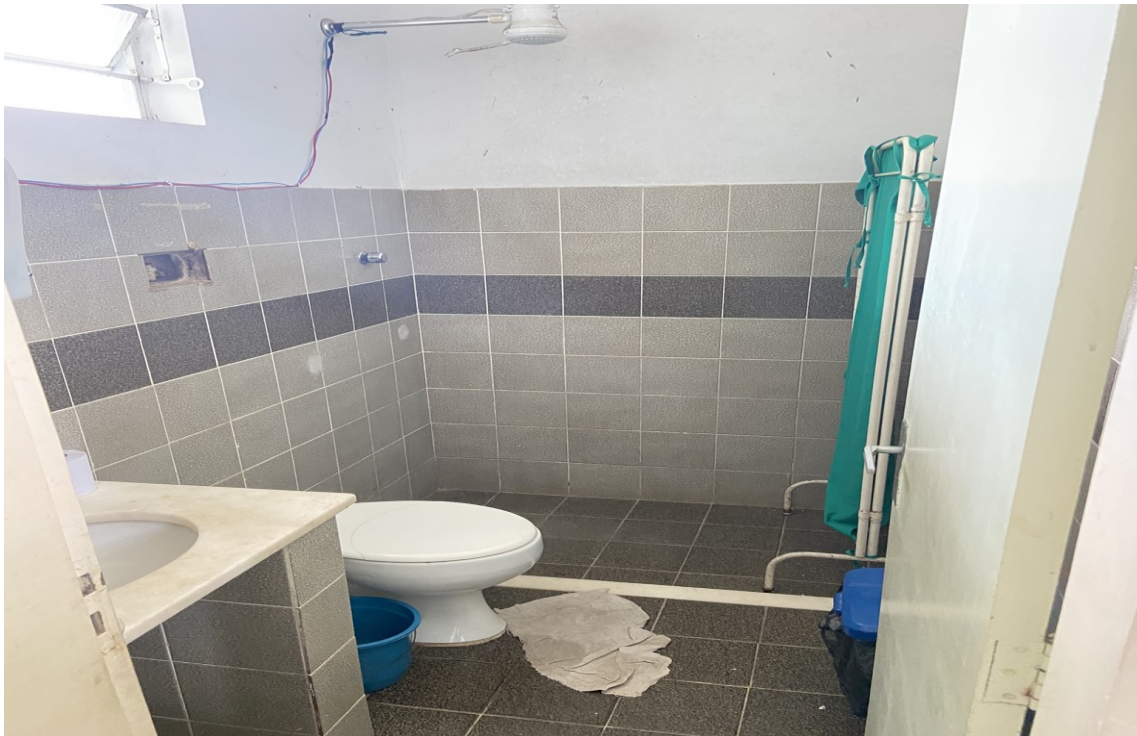
FOTO 12: BANHEIRO SALA ENFERMEIRA
