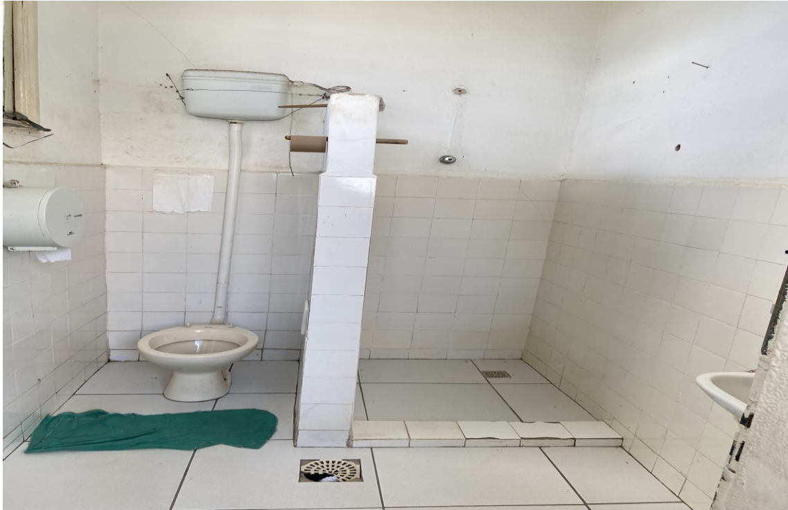
FOTO 25: BANHEIRO DOS FUNCIONÁRIOS
