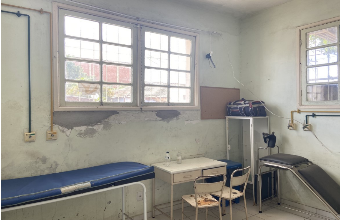
FOTO 19: SALA DOS ACS
