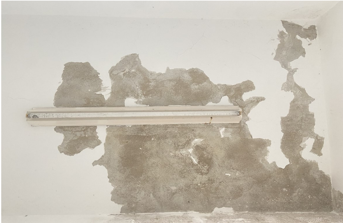
FOTO 13: BANHEIRO SALA ENFERMEIRA
