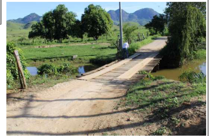
6 IMAGEM DO PONTO DE TRAVESSIA
