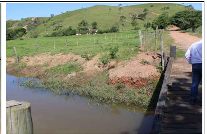
5 IMAGEM DO RIO E PARTE DA ESTRUTURA DA PONTE
