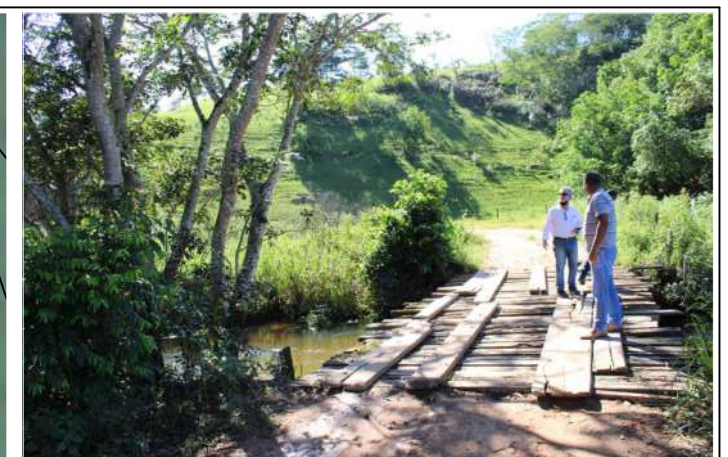
5 IMAGEM DO RIO NO PONTO DE TRAVESSIA
