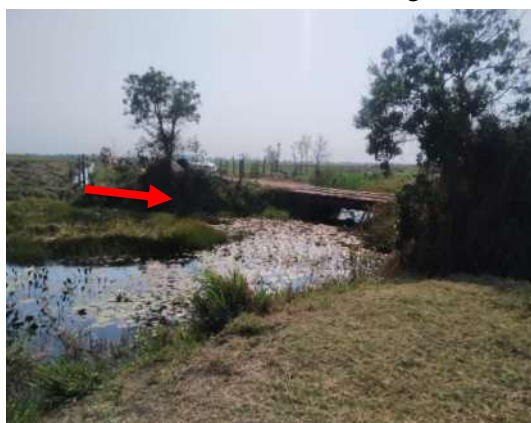
Figura 68 – Encontro realizado diretamente no solo.
