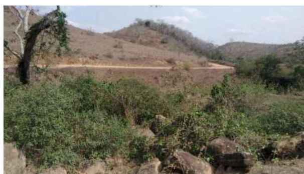
Figura 44 – Ausência de sinalização na pista.
