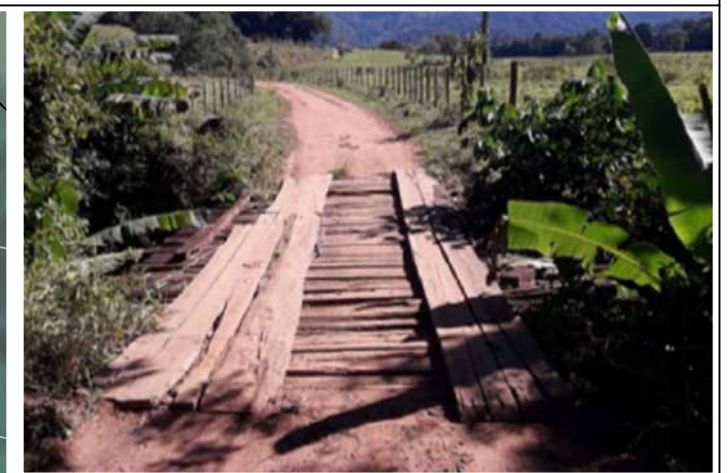
5 IMAGEM DA PONTE NO SENTIDO DA TRAVESSIA
