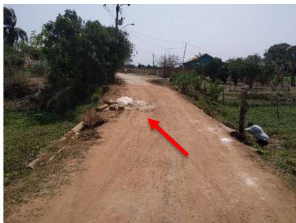
Figura 24 - Cobrimentos provisórios no afundamento do tabuleiro.
