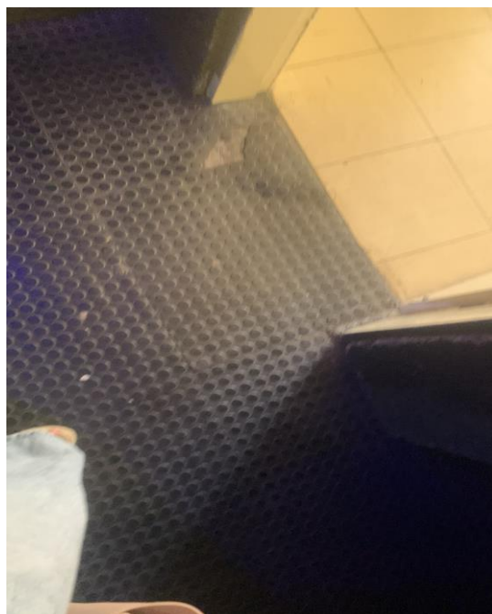
Figura 12 - Reparo no piso sintético
