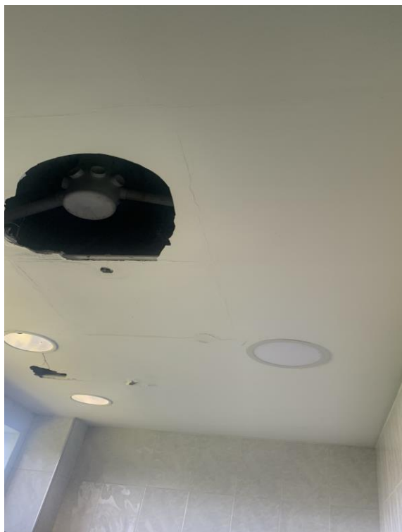
Figura 10 - Reparo no Gesso
