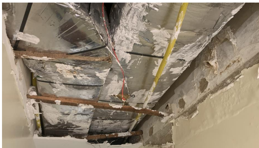
Figura 8 - Reparo no forro de Gesso
