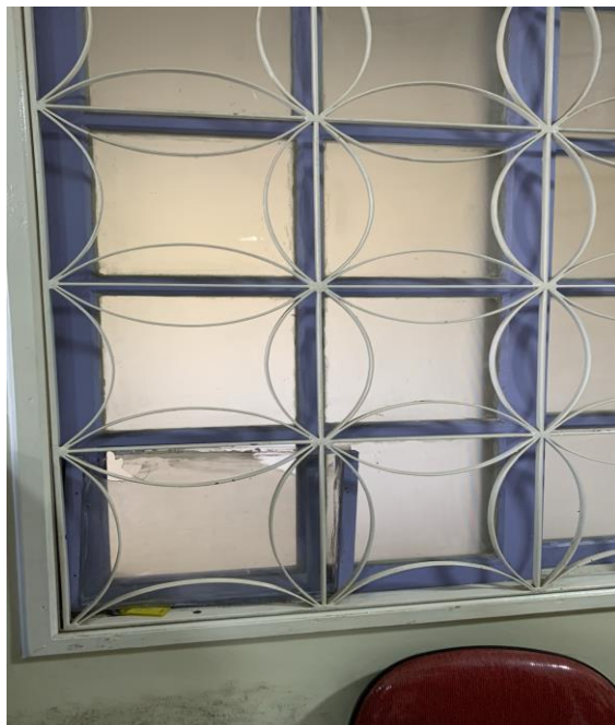
Figura 9 - Reparo no vidro da Janela
