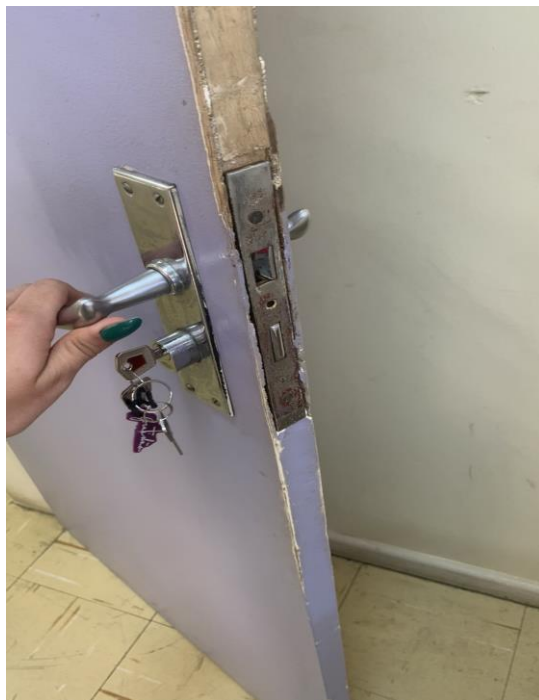
Figura 11 - Reparo na porta
