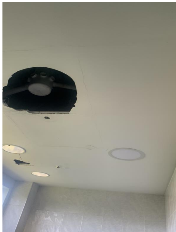
Figura 10 - Reparo no Gesso
