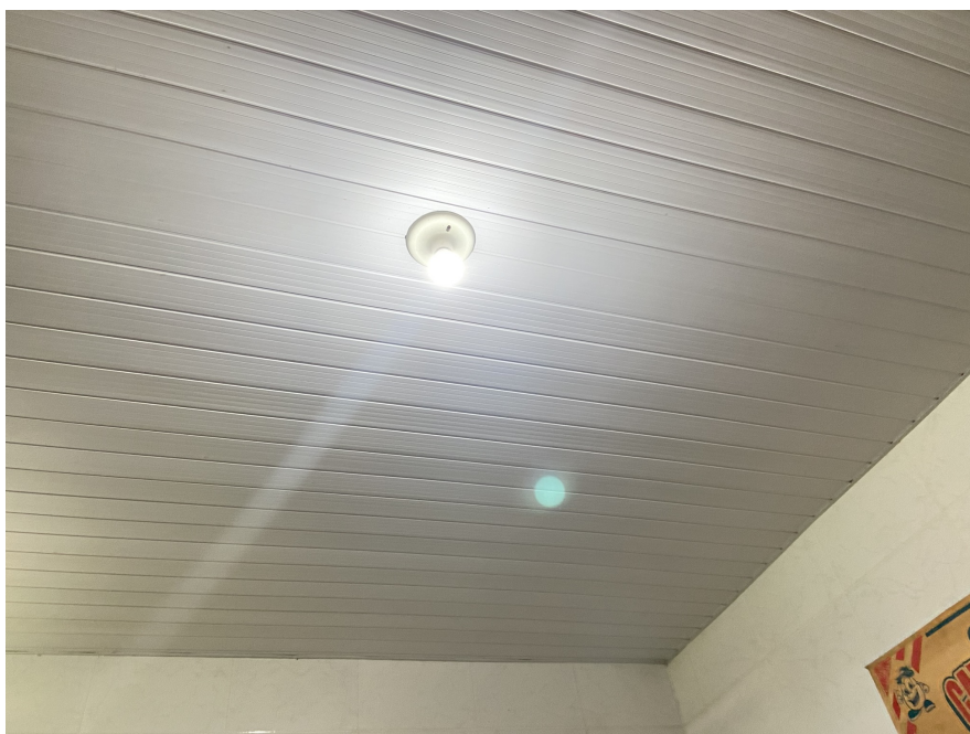
Foto 6: Reforma – Despensa Alimentos
