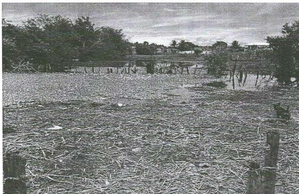
FOTO 2: Acesso ao alagamento pela Estrada Do Palacete
