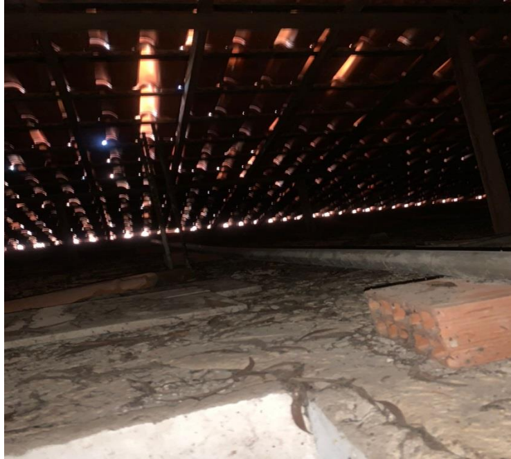
Telhado do Prédio Principal
