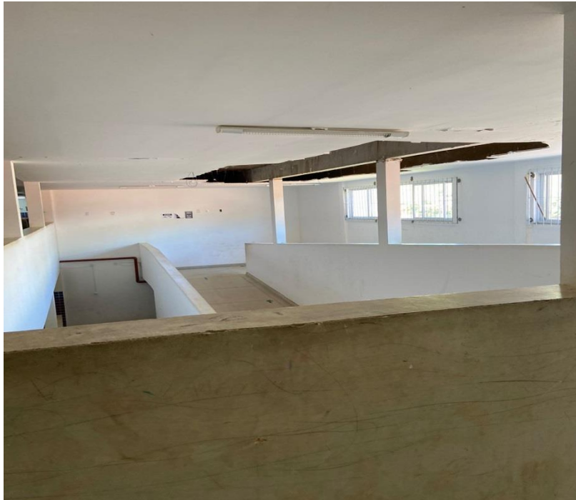
Rampa de acesso aos pavimentos superiores
