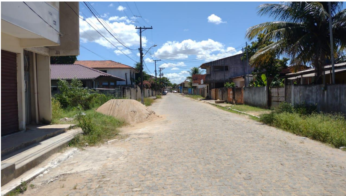
RUA PROJETADA B (trecho2)
