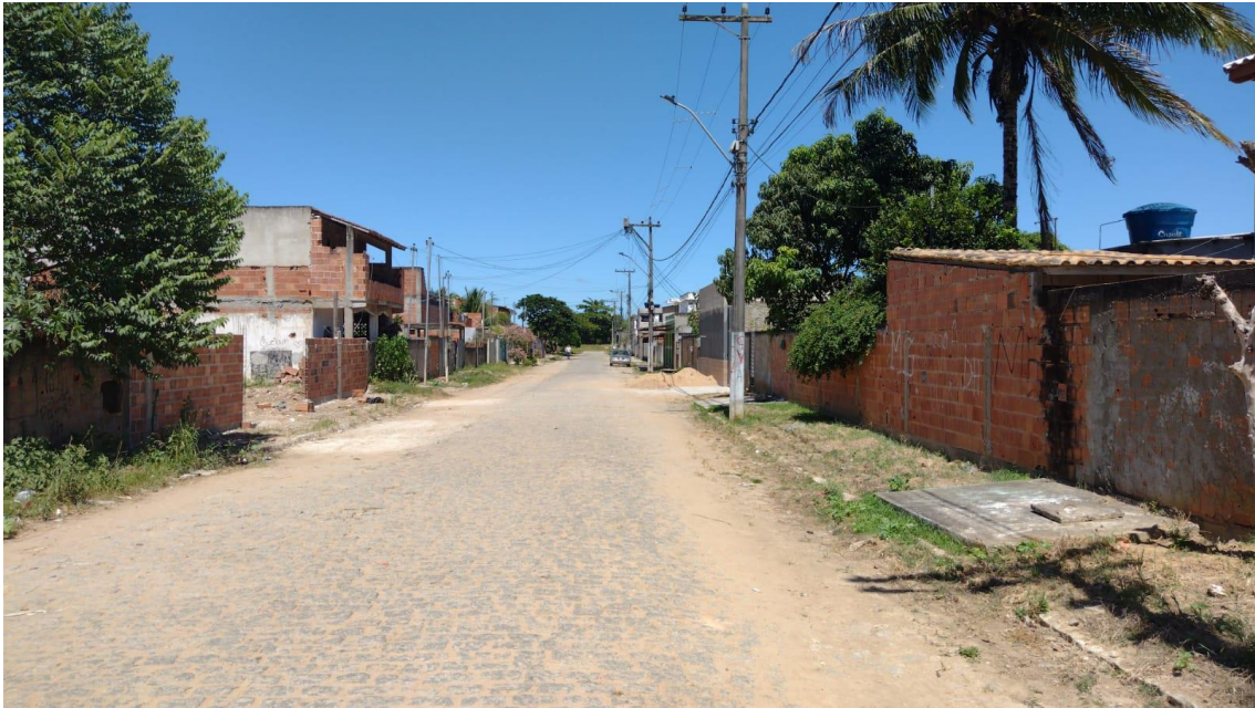
RUA PROJETADA TRES
