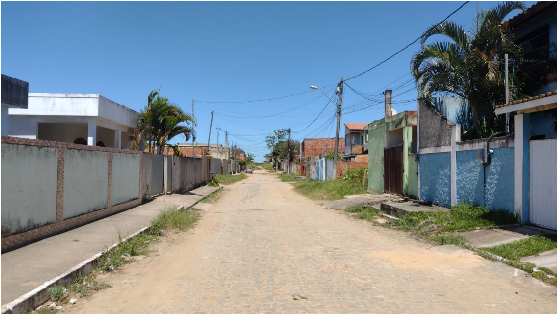
RUA PROJETADA B (trecho 1)
