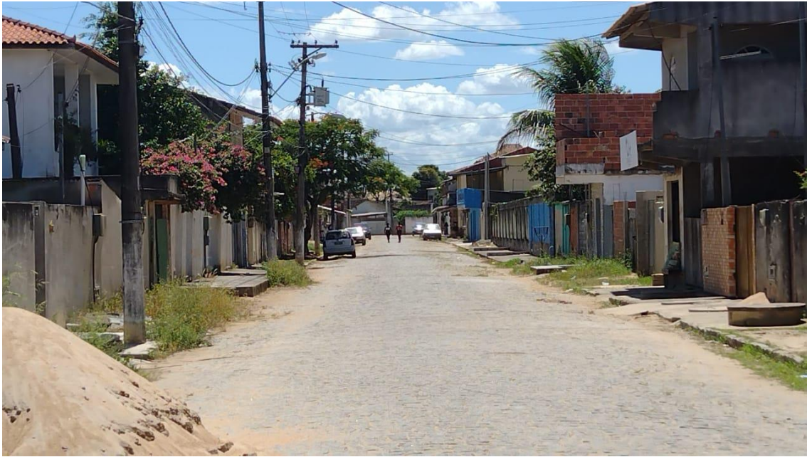
RUA PROJETADA B (trecho 2)
