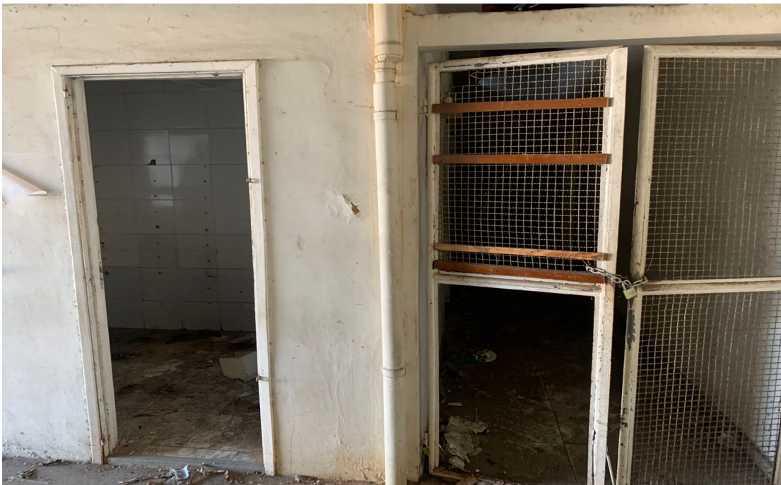
Foto 10: Circulação prédio principal
