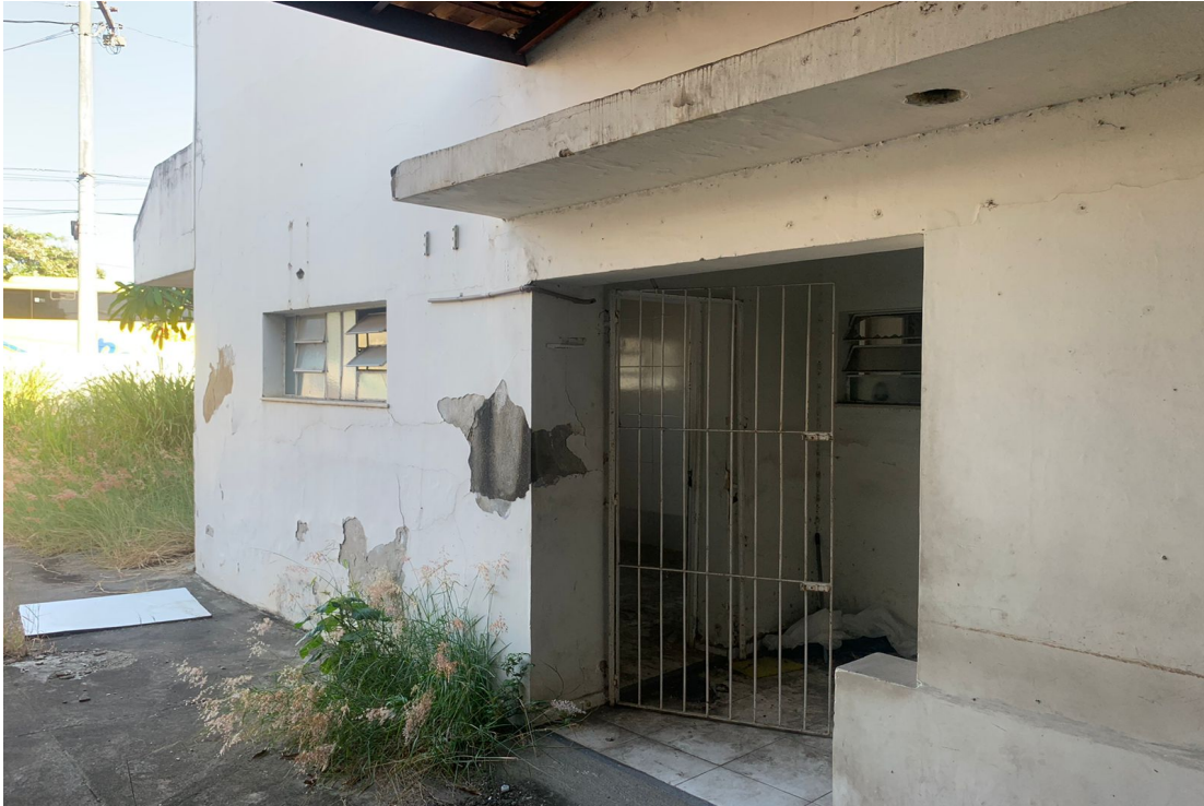
Foto 7: Acesso ao prédio principal (fundos)
