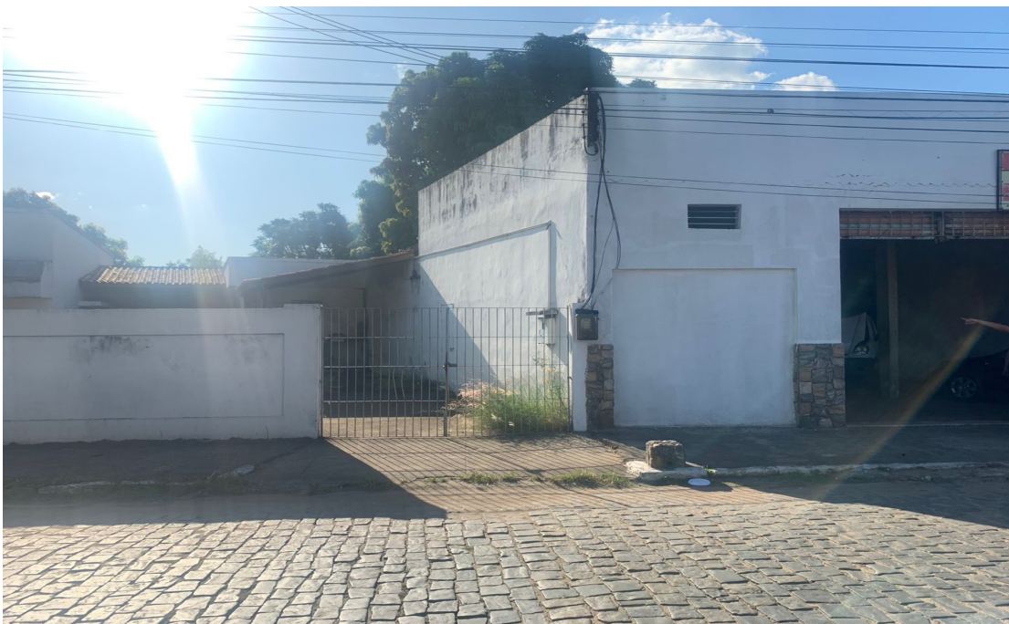
Foto 2: Fachada lateral e prédio anexo
