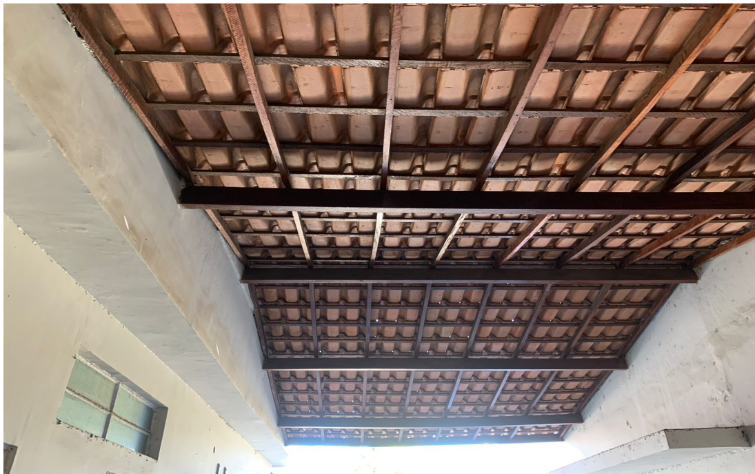
Foto 6: Circulação área externa (fundos)
