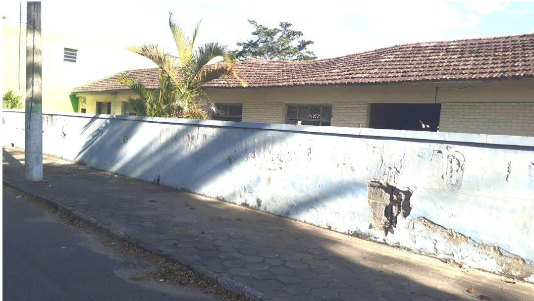
Foto 5: Demolição para construção da Escola Municipal Prof. Fernando de Andrade
