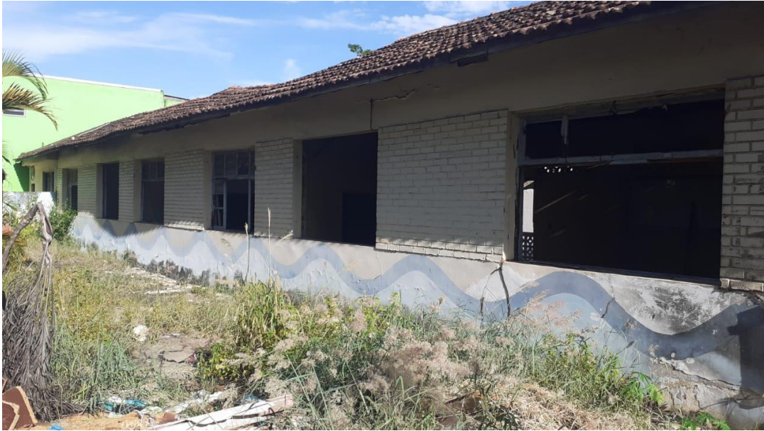
Foto 3: Demolição para construção da Escola Municipal Prof. Fernando de Andrade
