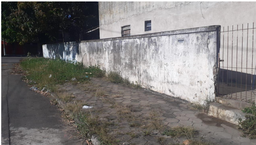
Foto 8: Reforma da calçada onde será a Escola Municipal Prof. Fernando de Andrade
