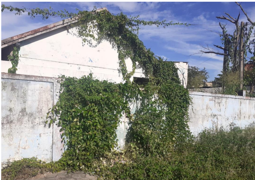
Foto 1: Demolição para construção da Escola Municipal Prof. Fernando de Andrade
