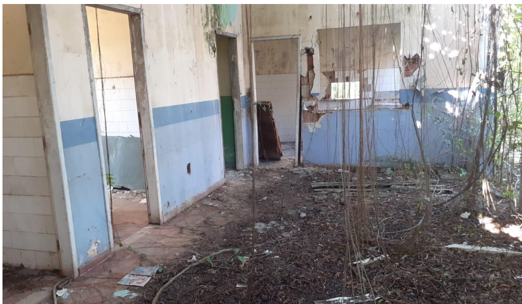
Foto 2: Demolição para construção da Escola Municipal Prof. Fernando de Andrade
