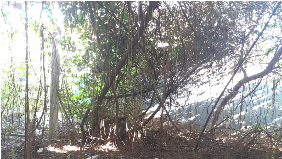
Foto 7: Limpeza onde será a Escola Municipal Prof. Fernando de Andrade
