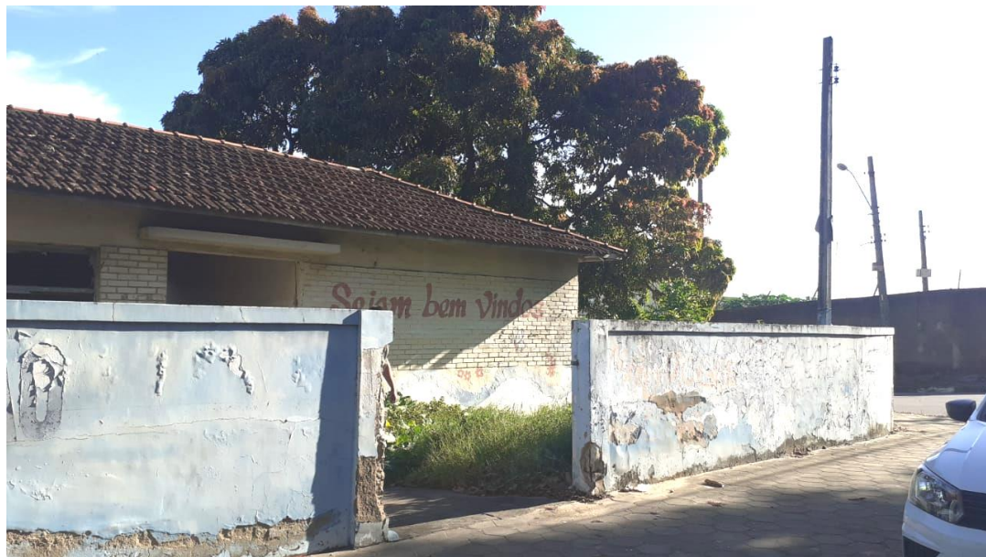
Foto 6: Demolição para construção da Escola Municipal Prof. Fernando de Andrade
