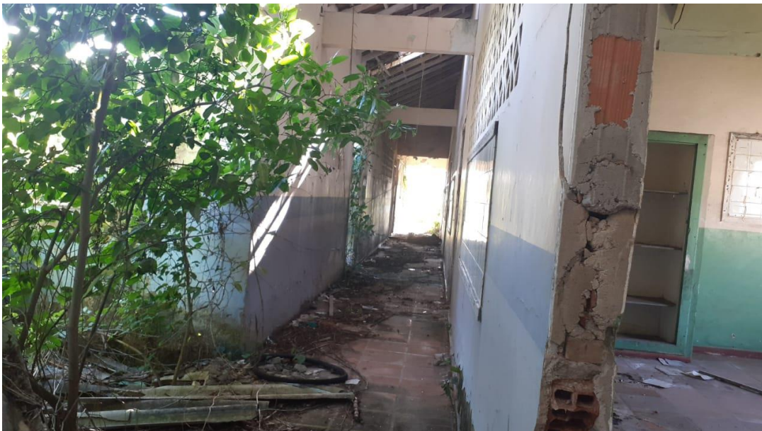
Foto 4: Demolição para construção da Escola Municipal Prof. Fernando de Andrade
