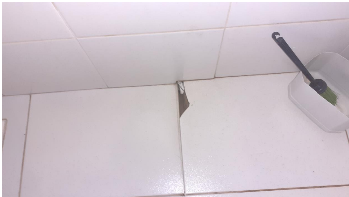
Foto 8: Reforma da UBS Parque Santos Dumont – Banheiro 01
