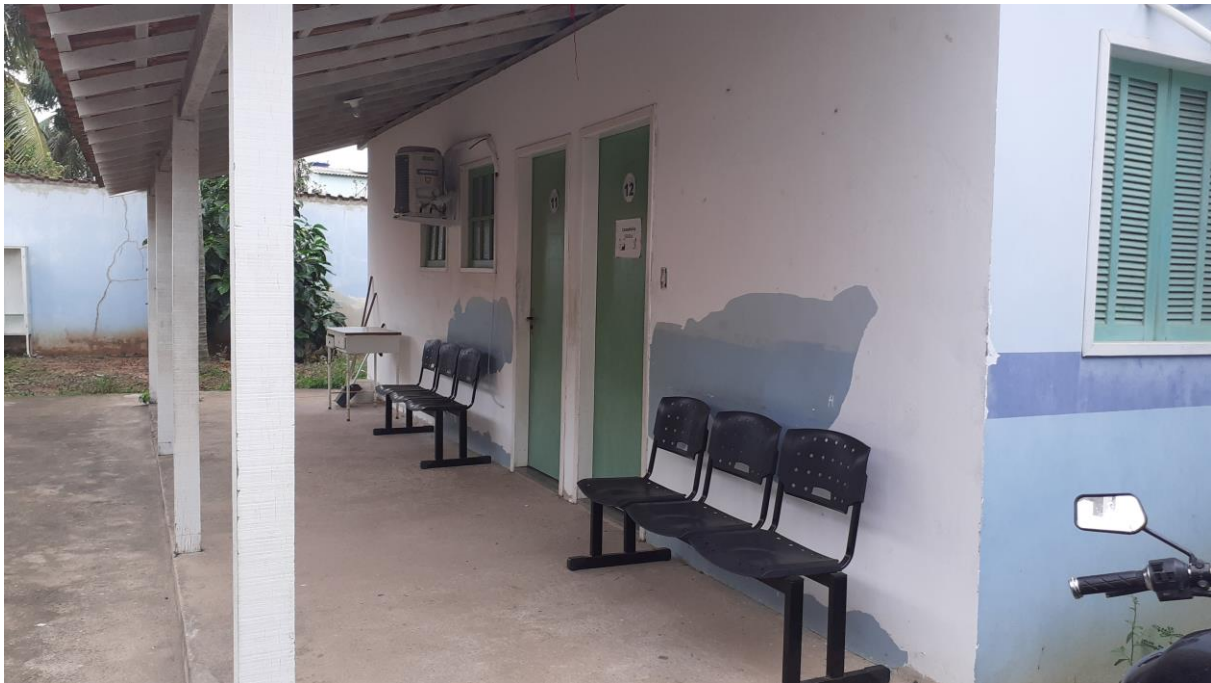
Foto 40: Reforma da UBS Parque Santos Dumont – Área Externa
