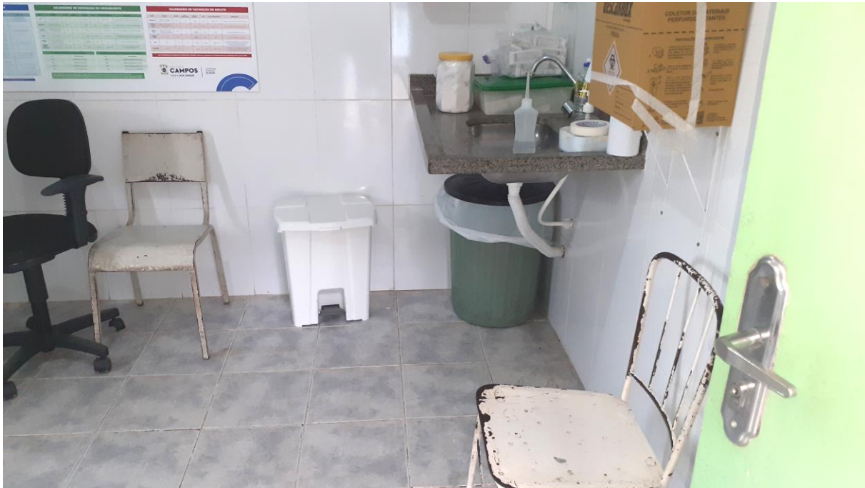
Foto 19: Reforma da UBS Parque Santos Dumont – Sala Vacina
