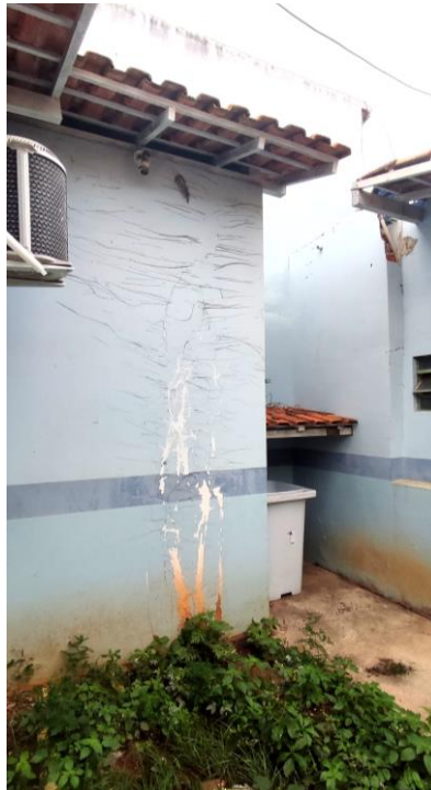
Foto 29: Reforma da UBS Parque Santos Dumont – Banheiro PCD: a ser construído
