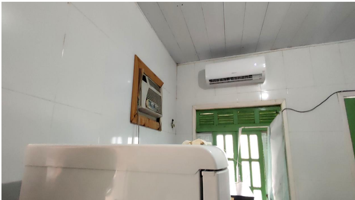
Foto 20: Reforma da UBS Parque Santos Dumont – Sala Vacina
