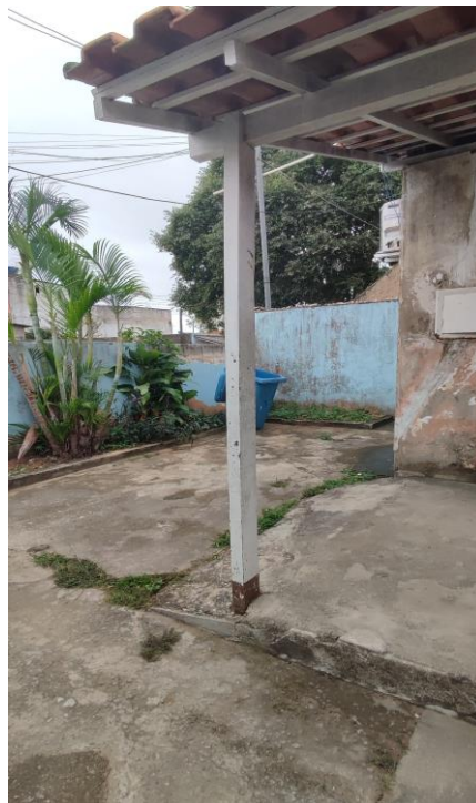
Foto 44: Reforma da UBS Parque Santos Dumont – Área Externa
