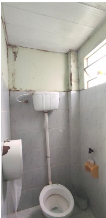
Foto 36: Reforma da UBS Parque Santos Dumont – Banheiro (Secretaria)
