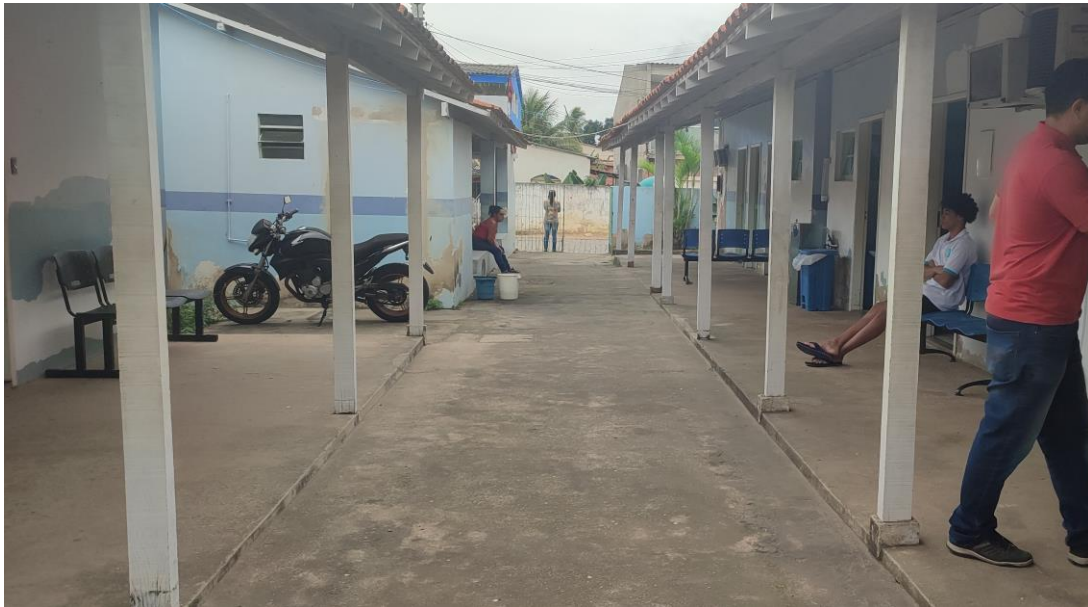
Foto 41: Reforma da UBS Parque Santos Dumont – Área Externa
