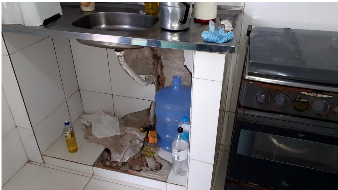
Foto 22: Reforma da UBS Parque Santos Dumont – Cozinha
