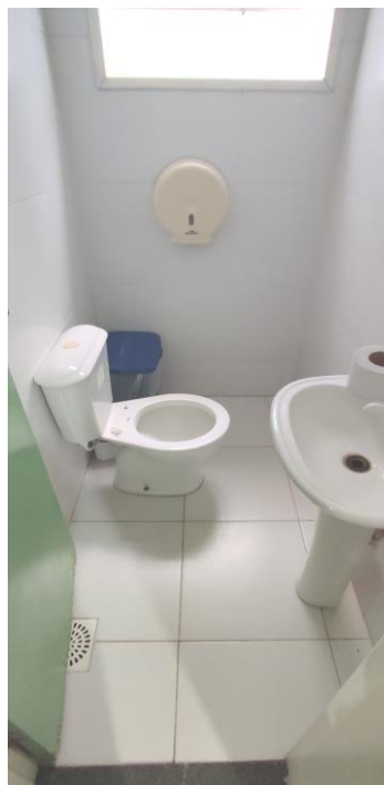
Foto 28: Reforma da UBS Parque Santos Dumont – Banheiro (Consultório)
