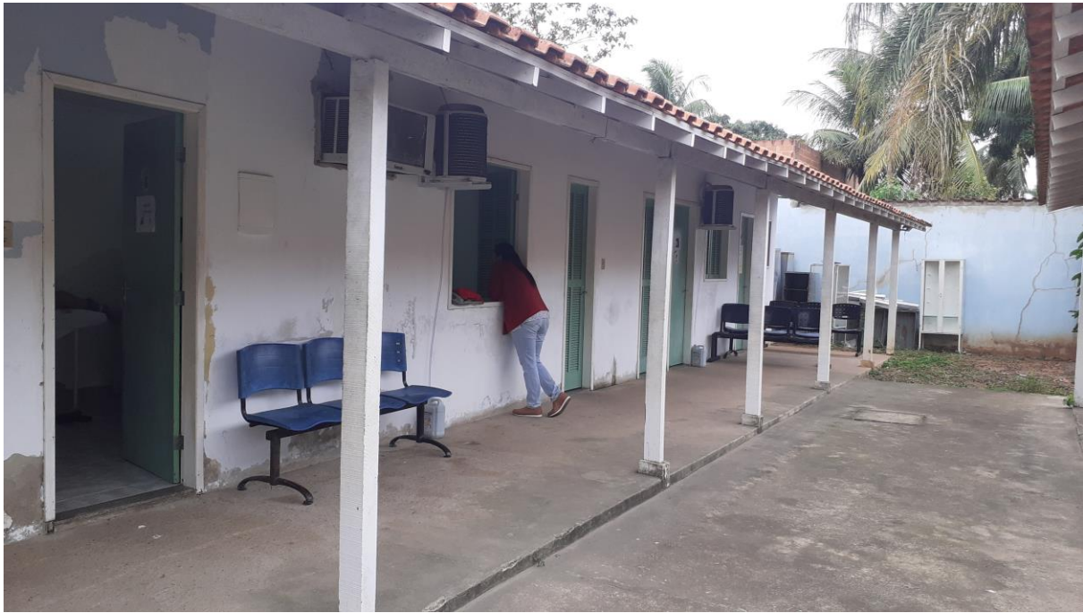
Foto 39: Reforma da UBS Parque Santos Dumont – Área Externa
