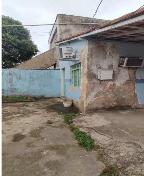
Foto 43: Reforma da UBS Parque Santos Dumont – Área Externa
