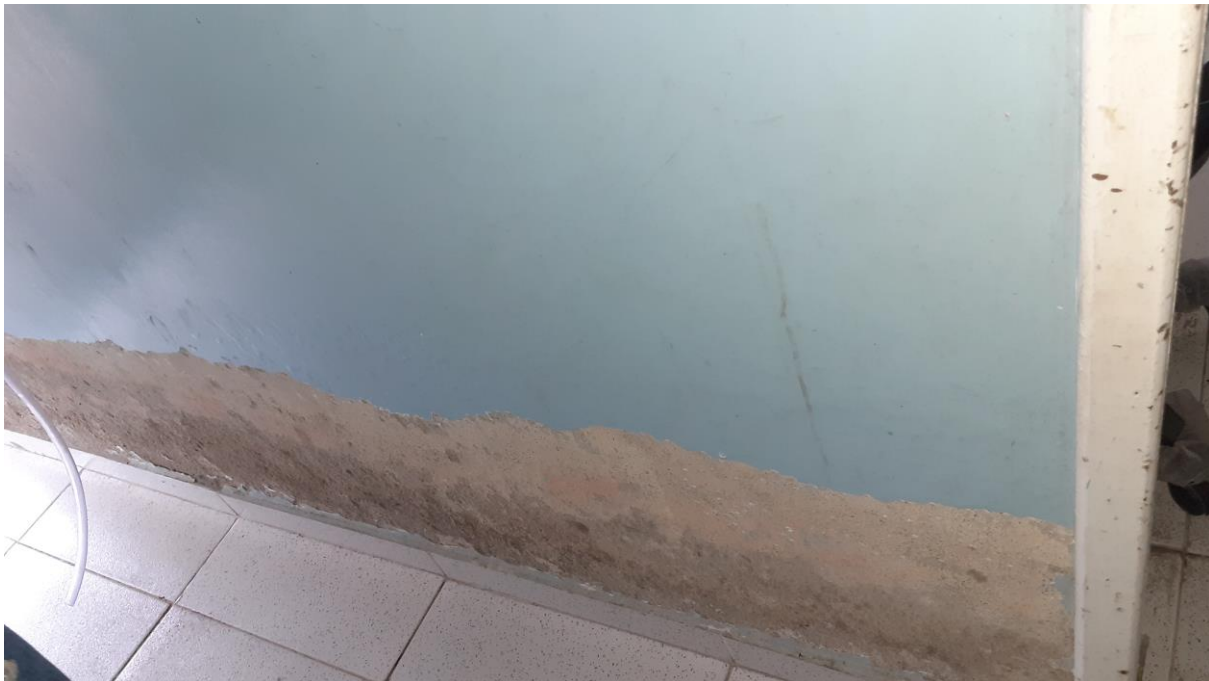
Foto 14: Reforma da UBS Parque Santos Dumont – Curativo 2 (ampliação)
