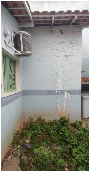
Foto 30: Reforma da UBS Parque Santos Dumont – Banheiro PCD: a ser construído
