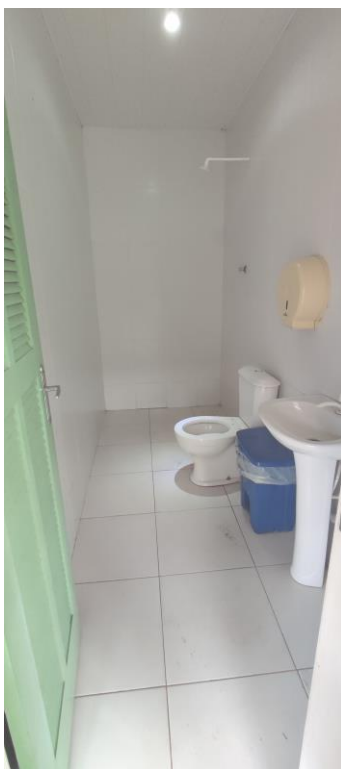
Foto 7: Reforma da UBS Parque Santos Dumont – Banheiro 01
