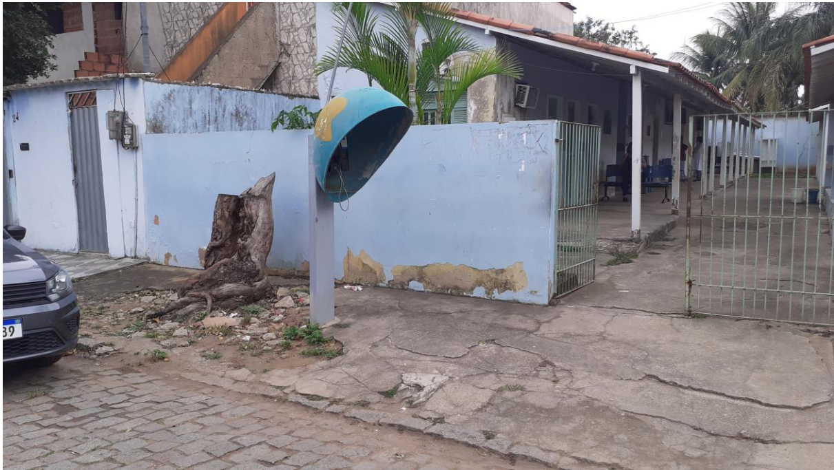
Foto 47: Reforma da UBS Parque Santos Dumont – Área Externa
