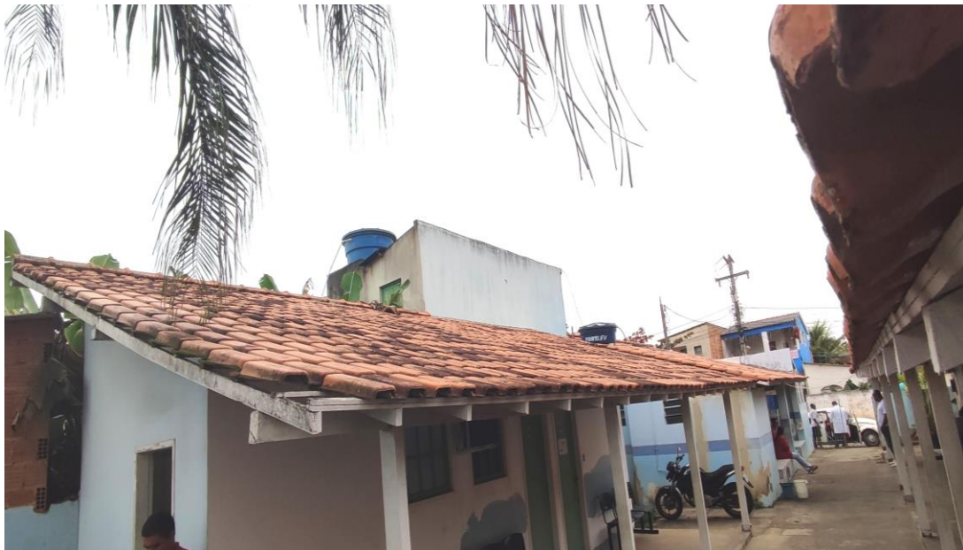
Foto 42: Reforma da UBS Parque Santos Dumont – Área Externa
