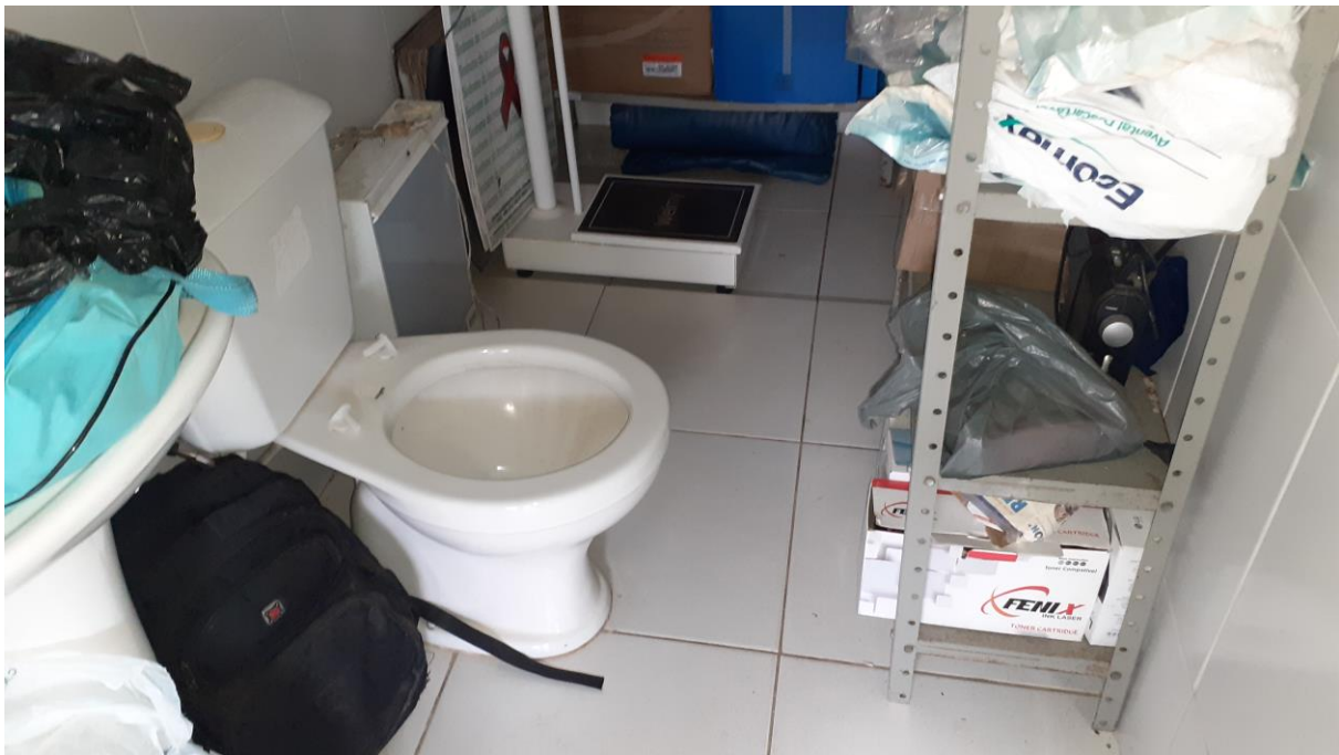
Foto 6: Reforma da UBS Parque Santos Dumont – Banheiro 02
