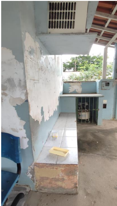
Foto 45: Reforma da UBS Parque Santos Dumont – Área Externa
