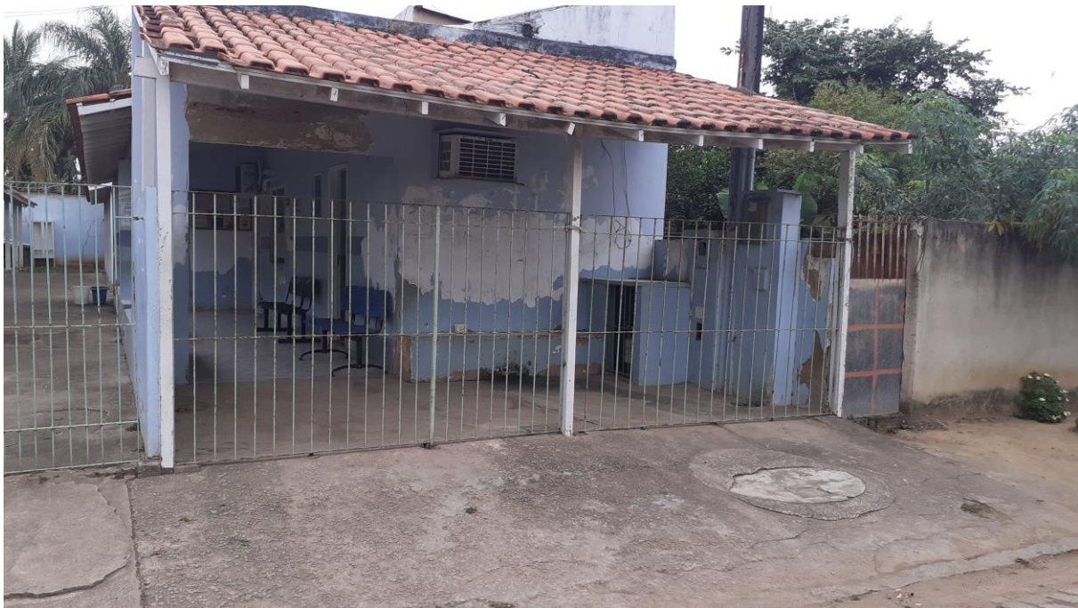
Foto 48: Reforma da UBS Parque Santos Dumont – Área Externa
