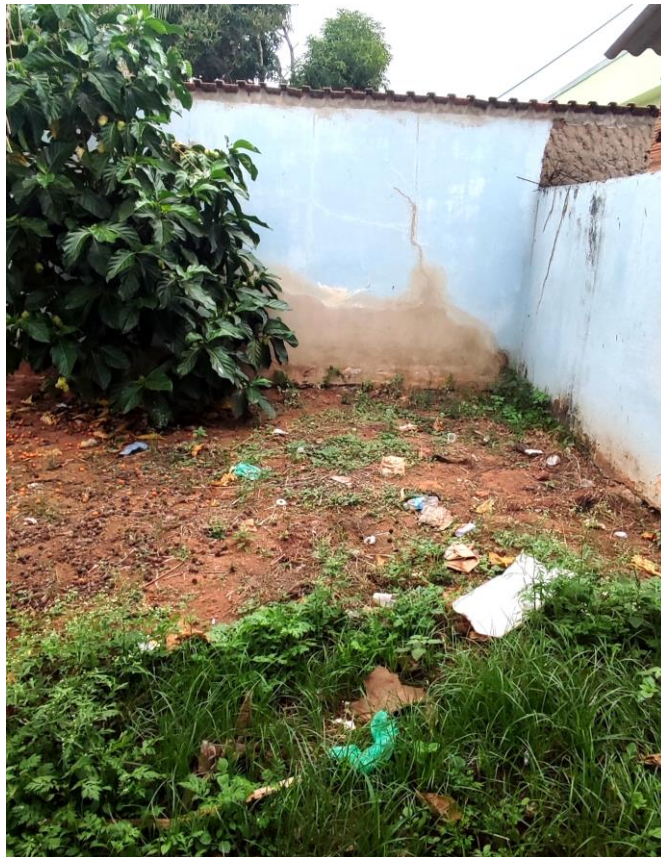
Foto 50: Reforma da UBS Parque Santos Dumont – Fundos
