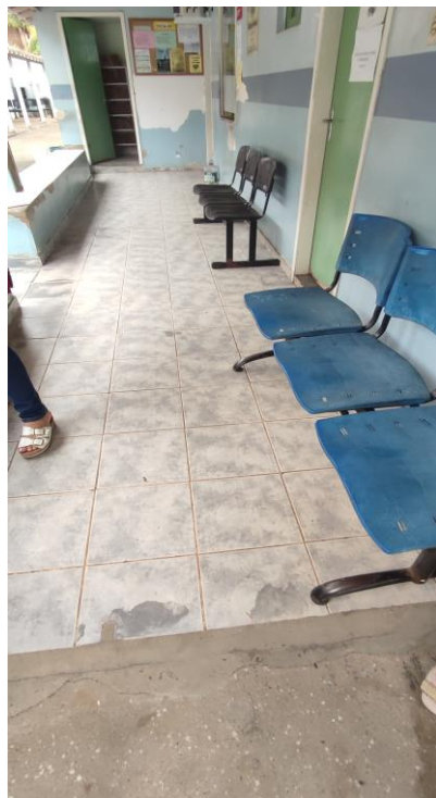
Foto 46: Reforma da UBS Parque Santos Dumont – Área Externa
