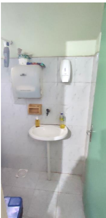
Foto 35: Reforma da UBS Parque Santos Dumont – Banheiro (Secretaria)
