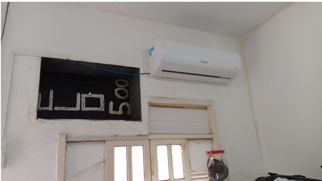
Foto 18 – Fechar vão do ar condicionado antigo
