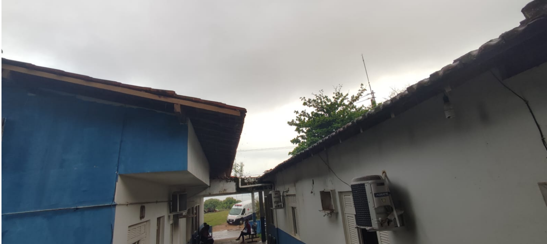
Foto 05 - Troca das telhas francesas do prédio principal e prolongamento do telhado
