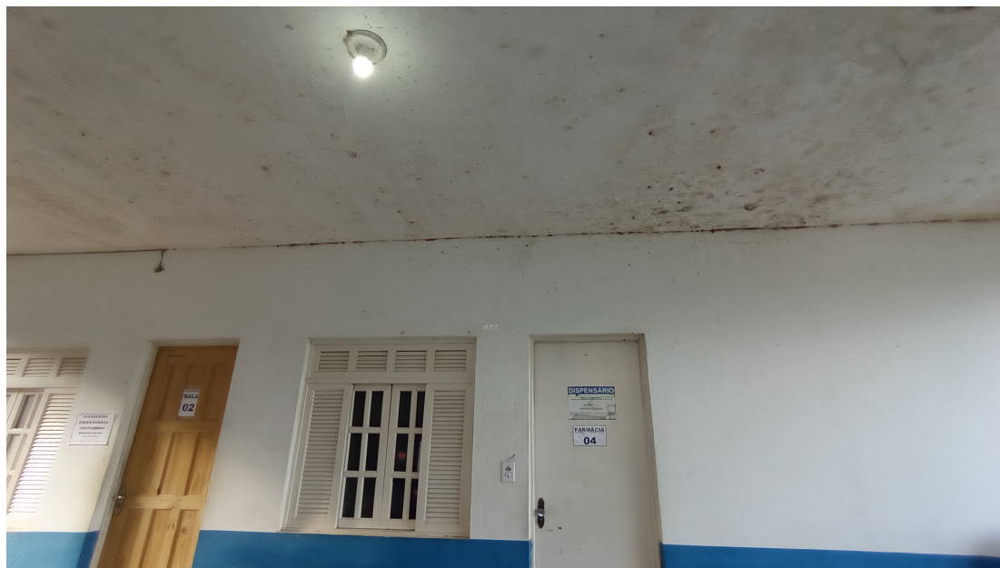
Foto 15 – Troca das portas e janelas
