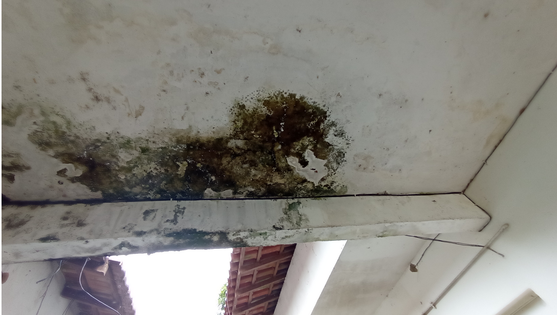
Foto 11 – Raspagem da laje na cobertura da varanda 02
