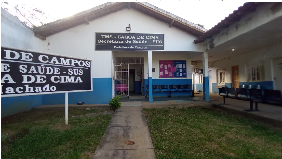
Foto 06 - Construção de rampa nova de acessibilidade na entrada
