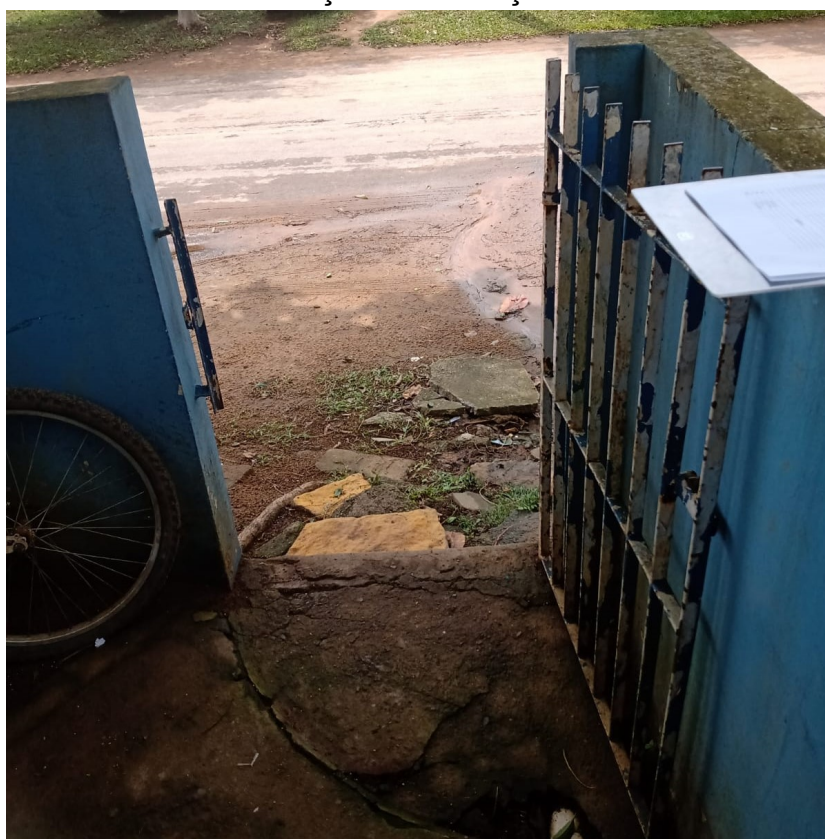
Foto 28 – Construção de rampa nova na entrada do correios
