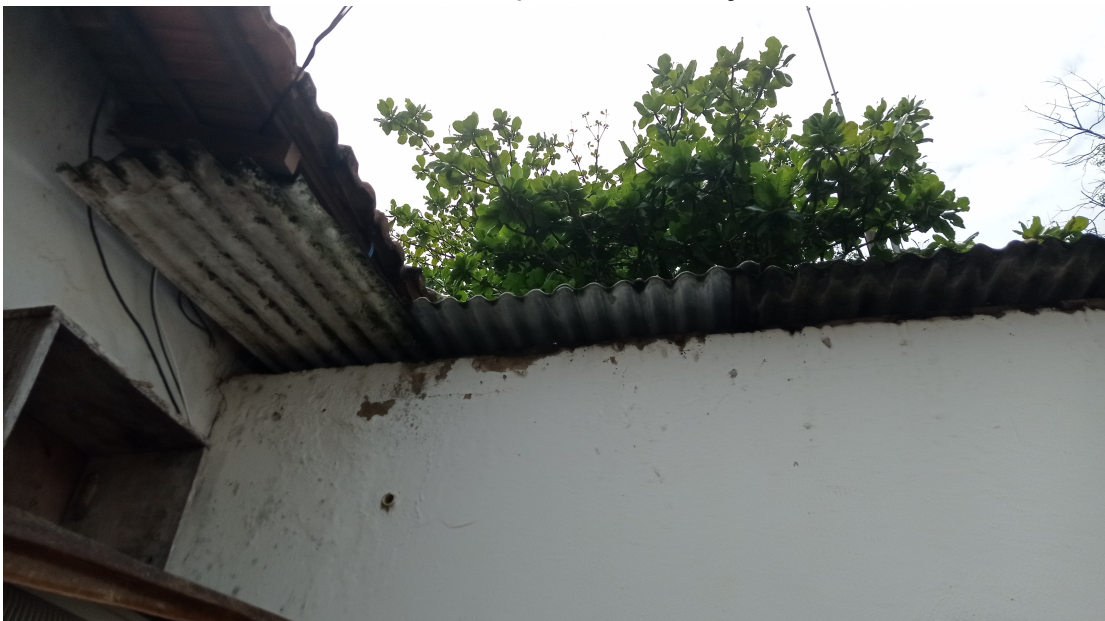
Foto 24 – Remoção da telha de fibrocimento no correios
