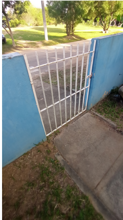
Foto 03 – Troca do portão
