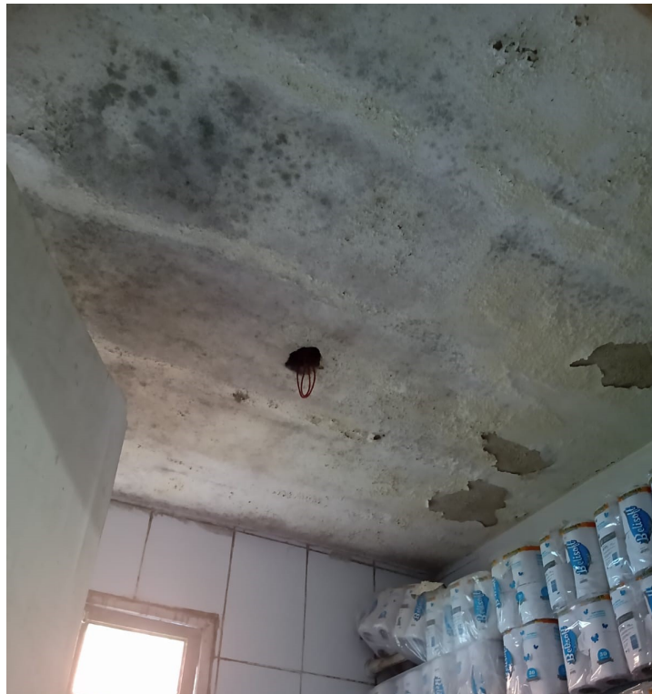
Foto 22 – Raspagem no teto alcoxarifado
