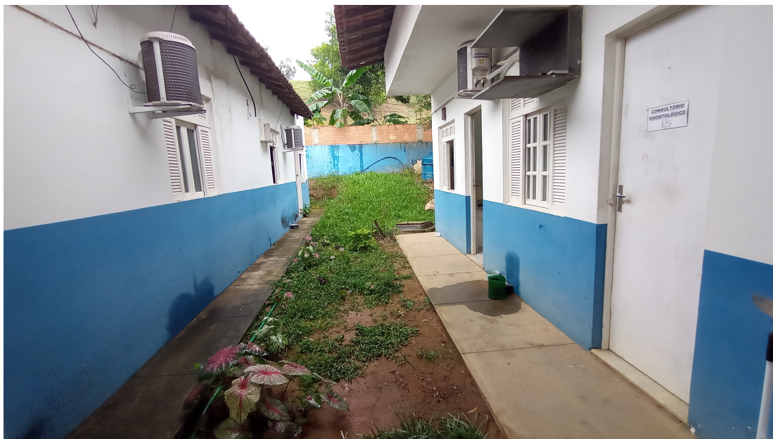
Foto 07 – Pátio cimentado novo
