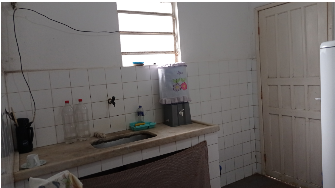
Foto 20 – Troca da bancada e revestimento na cozinha
