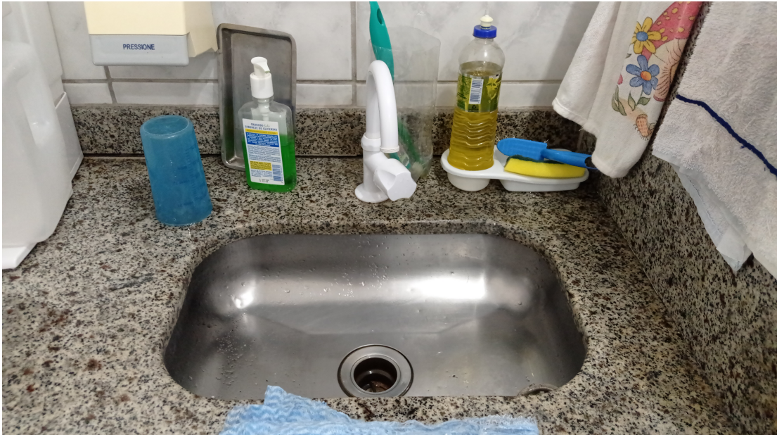
Foto 17 – Instalação de torneiras novas nos consultórios
