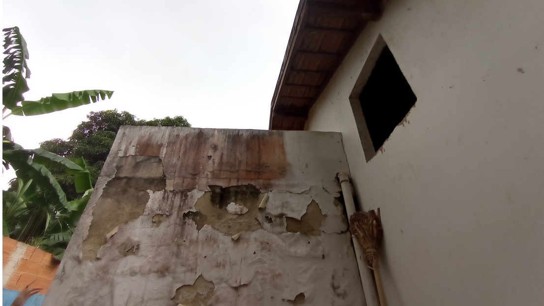
Foto 13 – Raspagem de parede
