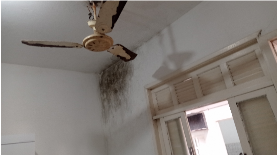
Foto 19 – Remoção do ventilador, troca de janela e raspagem na parede
