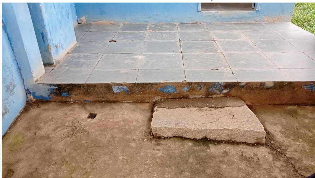
Foto 26 – Construção de rampa nova no correios
