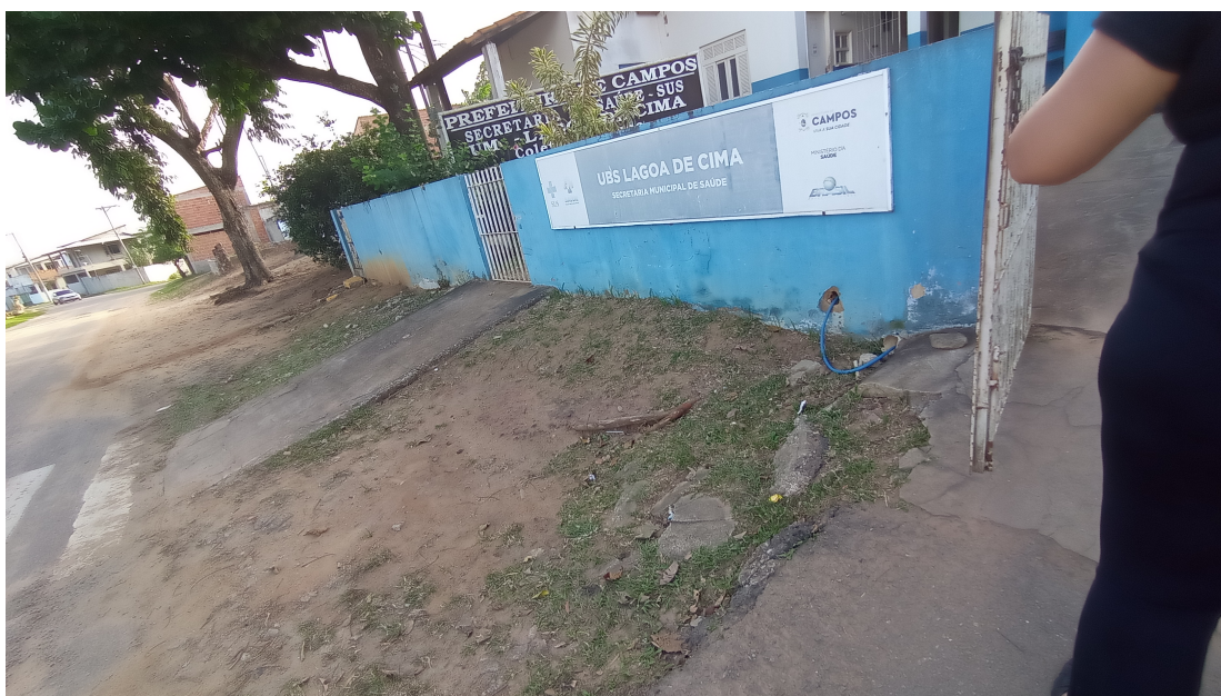
Foto 02 – Construção de calçamento público novo na entrada
