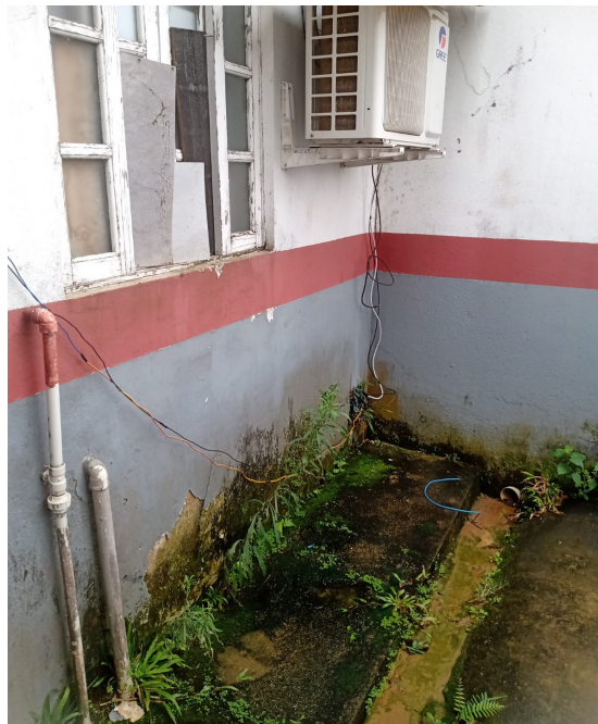
Foto 10 – Raspagem de parede
