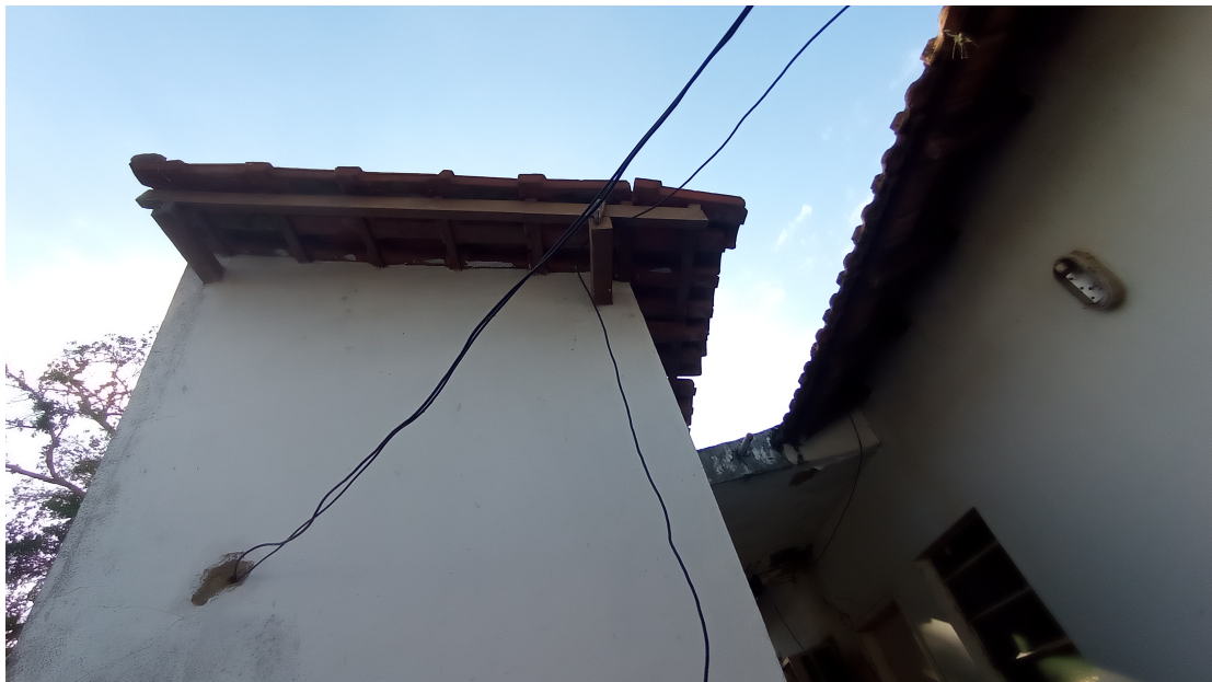
Foto 14 – Prolongamento do telhado na área de serviço
