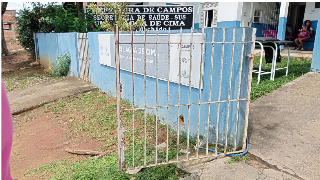
Foto 04 – Troca do portão da garagem
