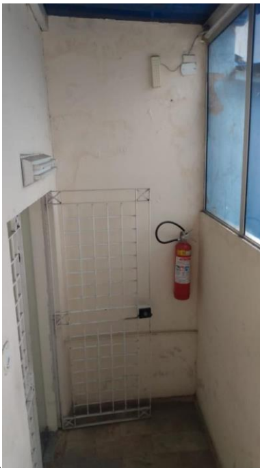
FOTO 7: Acesso ao prédio principal
