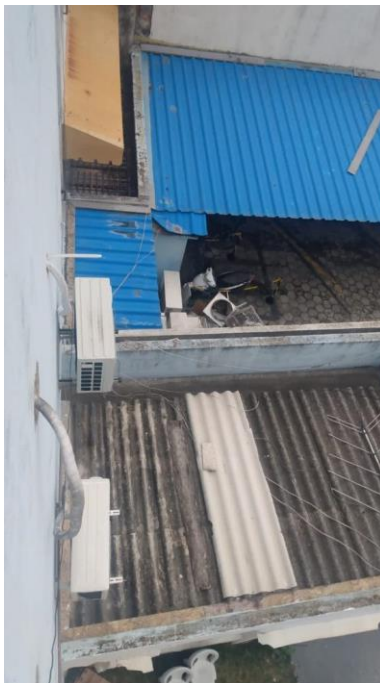
FOTO 27: Cobertura cômodo à demolir
