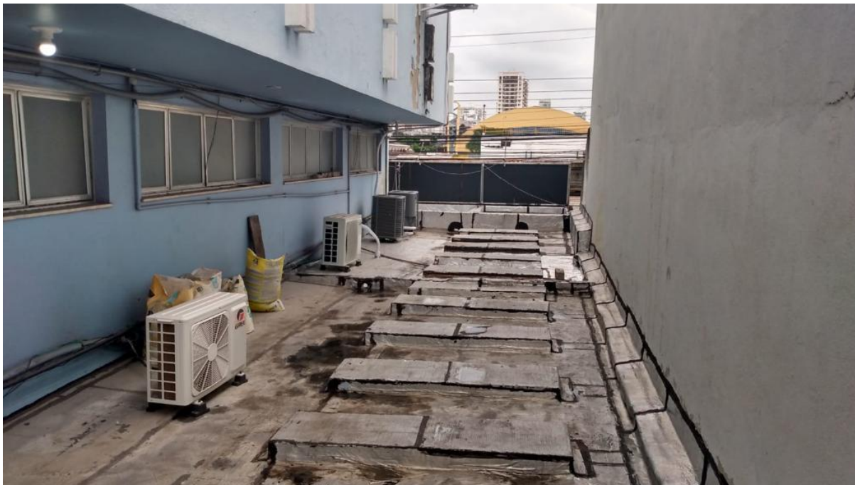
FOTO 13: Laje primeiro pavimento
