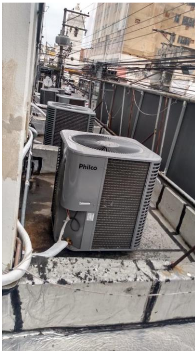
FOTO 14: Laje primeiro pavimento
