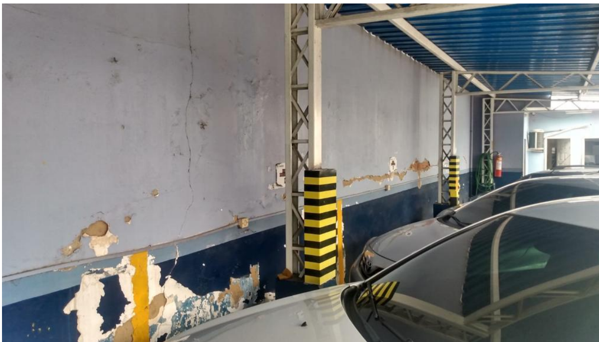
FOTO 28: Estrutura metálica estacionamento
