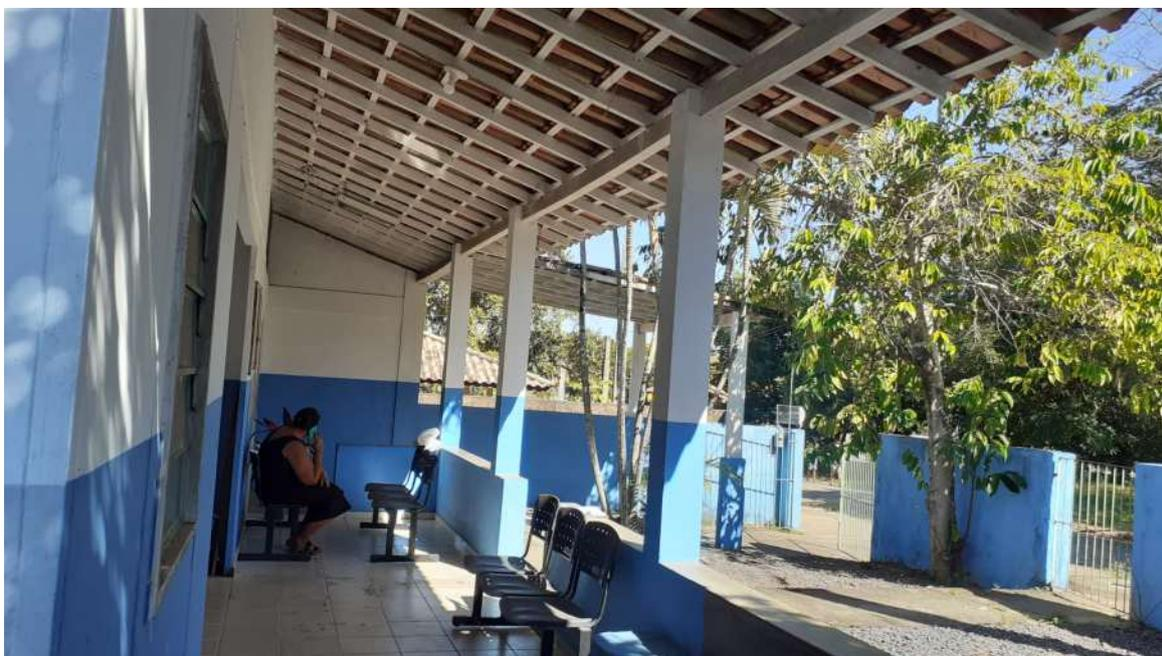
Foto 8: Reforma da UBS de Serrinha – Varanda 01 e Garagem Ambulância: Colocação de cobogó em frente das portas do W.C. 1 e W.C. 2; Limpeza de telhas; Troca das telhas danificadas
