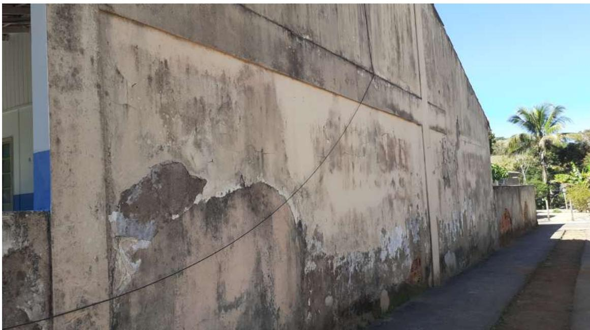
Foto 57: Reforma da UBS de Serrinha – Área Lateral: Demolição de emboço; Aplicação de argamassa com impermeabilizante
