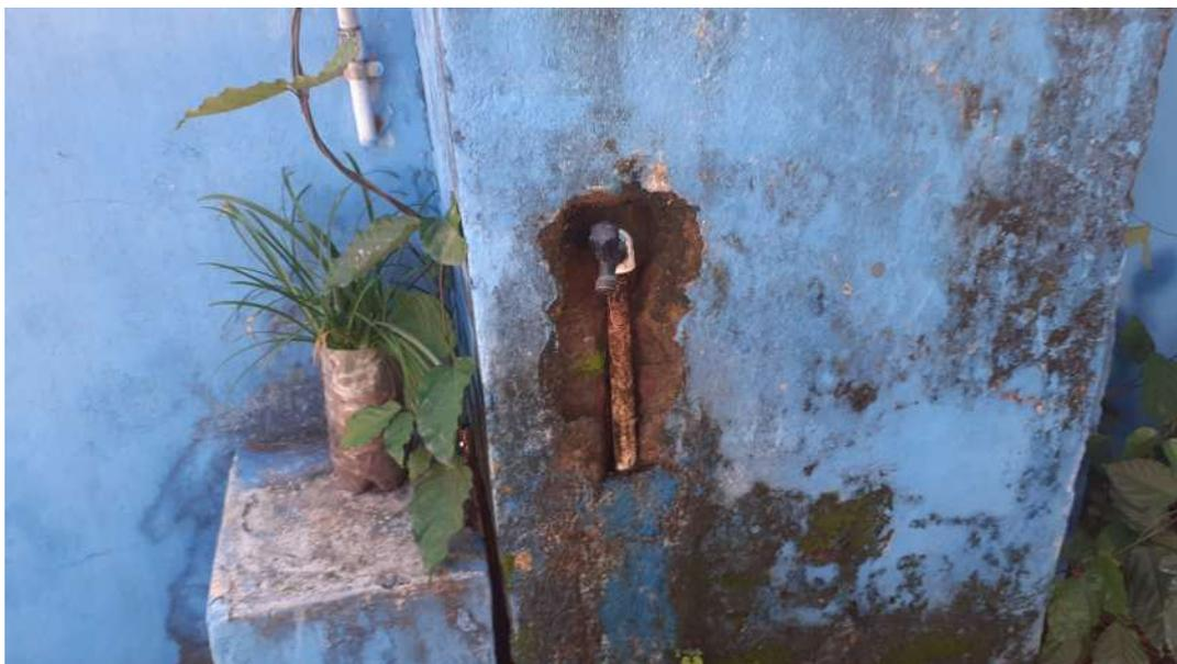
Foto 5: Reforma da UBS de Serrinha – Frente: Troca de torneira; Recomposição da parede
