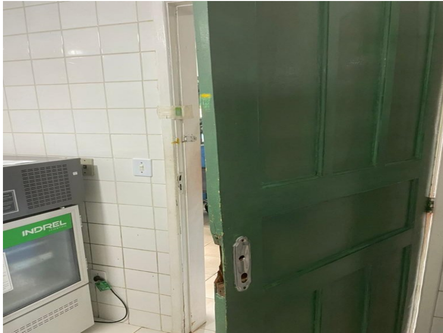
FOTO 17: Sala de imunização
