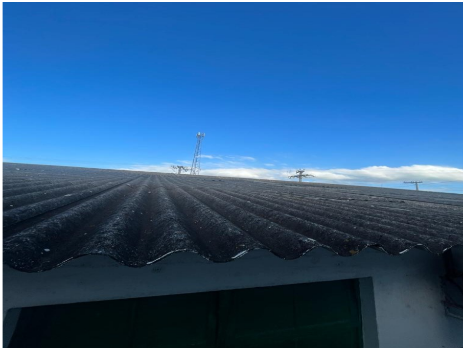
FOTO 20: Cobertura em telhas de fibrocimento
