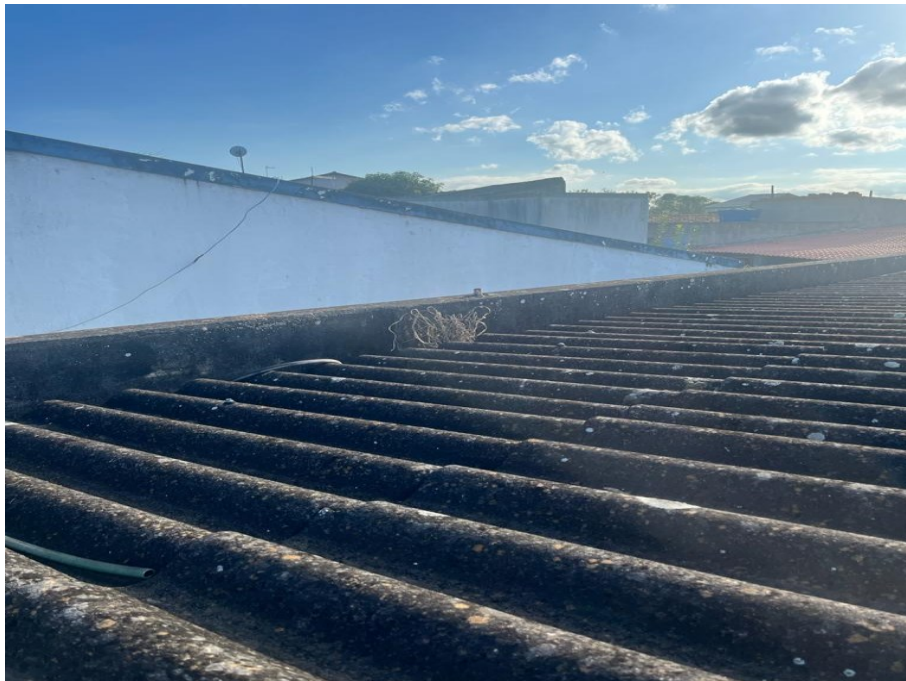
FOTO 22: Cobertura em telhas de fibrocimento
