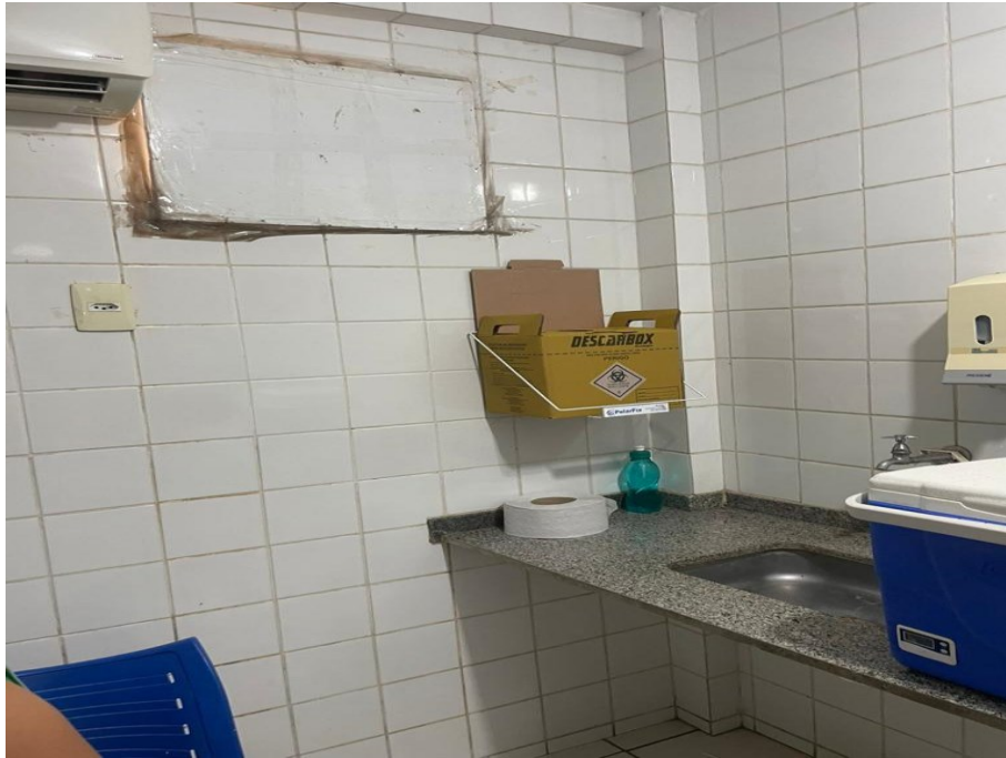
FOTO 19: Sala de imunização
