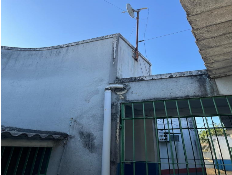
FOTO 11: Hall de passagem para o prédio dos fundos
