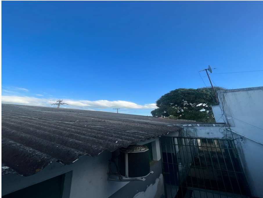
FOTO 21: Cobertura em telhas de fibrocimento
