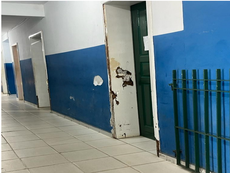
FOTO 12: Circulação (prédio principal)
