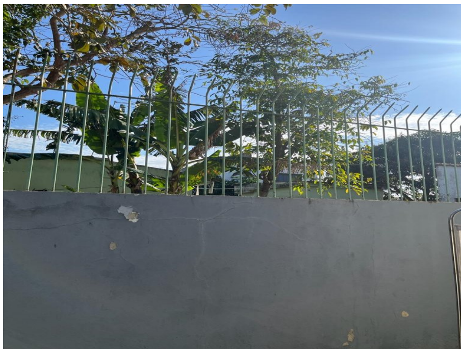
FOTO 7: Muro lateral com grade de ferro
