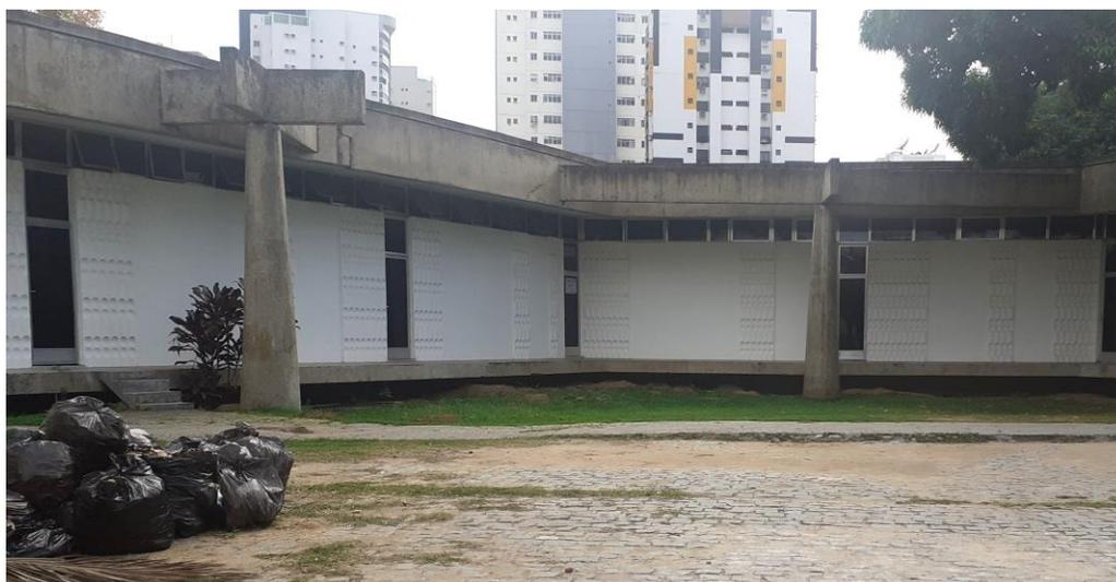
Foto 66: Tratamento do concreto aparente (área interna e externa) – Limpeza; Estucamento; Lixamento e Envernizamento
