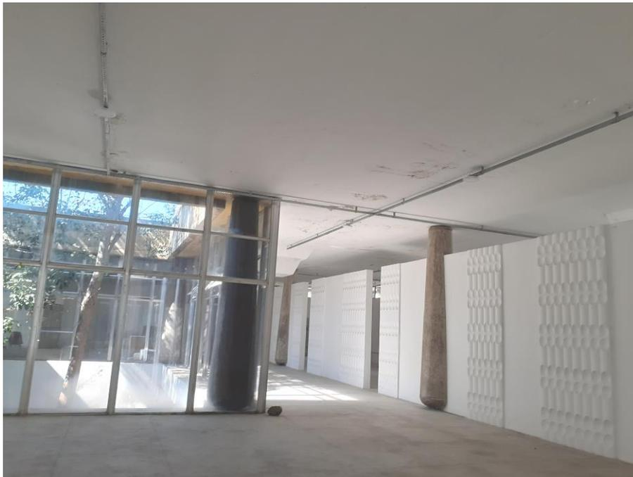
Foto 52: Sala de Reuniões (2), Podcast – Limpeza de piso (com polimento) e vidros (C4 e D3); Colocação de divisória; Pintura (parede, teto e divisória); Colocação de revestimento acústico e P6 no Podcast
