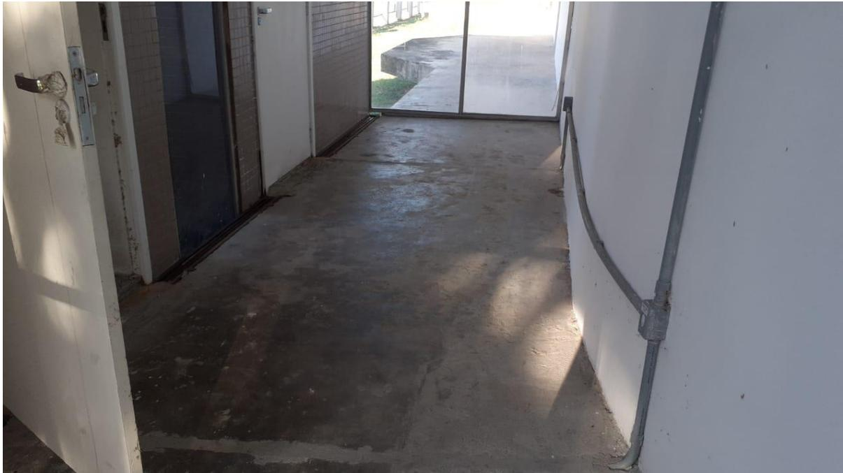
Foto 61: Circulação para acesso ao Camarim e Sanitário (5) – Colocação de piso de granilite; Limpeza de piso e vidros; Pintura da parede
