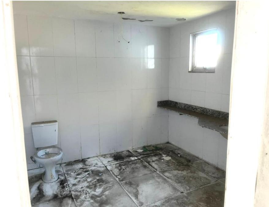
Foto 59: Sanitário (5) - próximo do Camarim – Limpeza de piso, vidros e parede; Colocação de divisória, vaso sanitário
