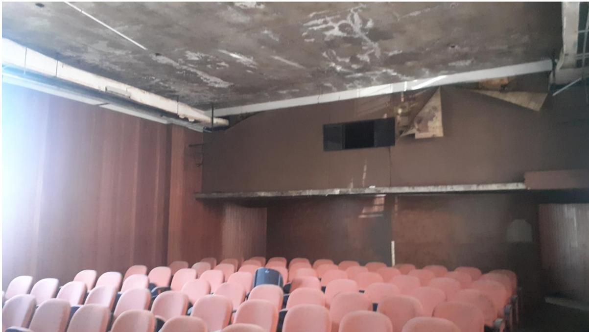
Foto 54: Auditório – Recomposição do revestimento da parede
