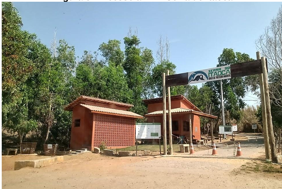
Figura 3 – Acesso à APA Serra do Itaóca
