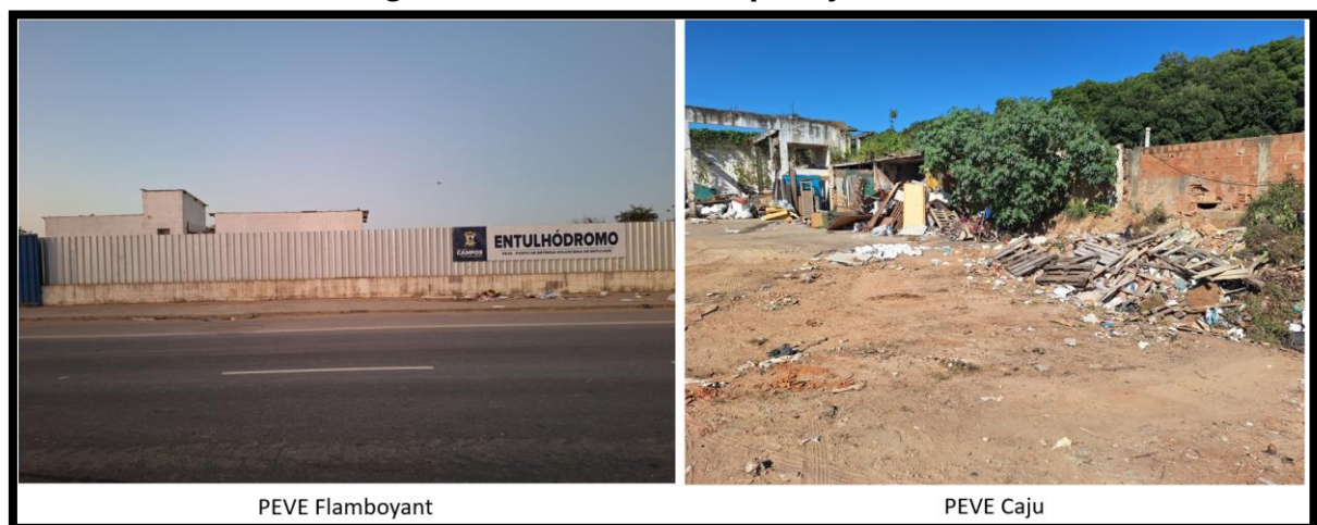
Figura 23 – PEVEs em operação
