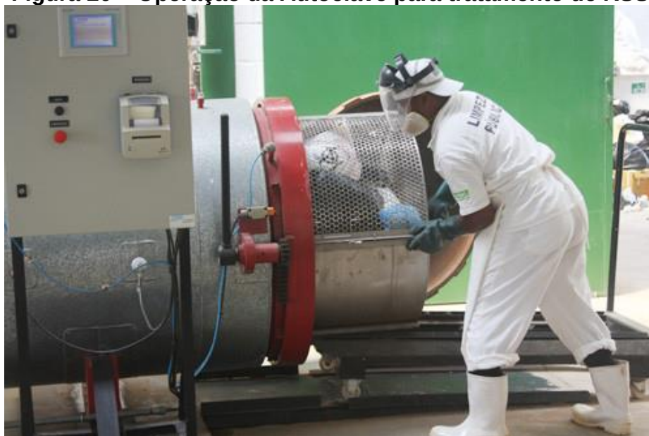
Figura 20 – Operação da Autoclave para tratamento de RSS
