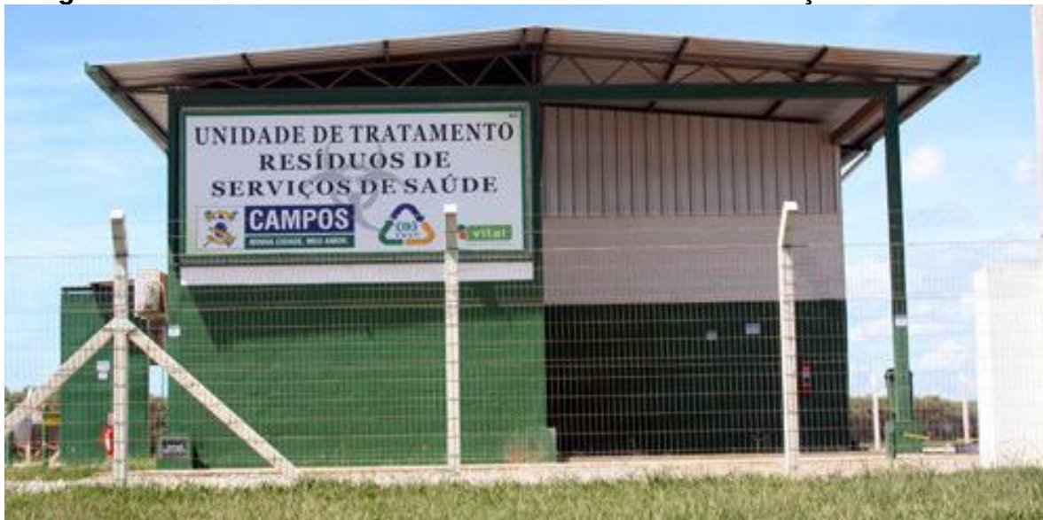
Figura 19 – Unidade de Tratamento de Resíduos de Serviços de Saúde
