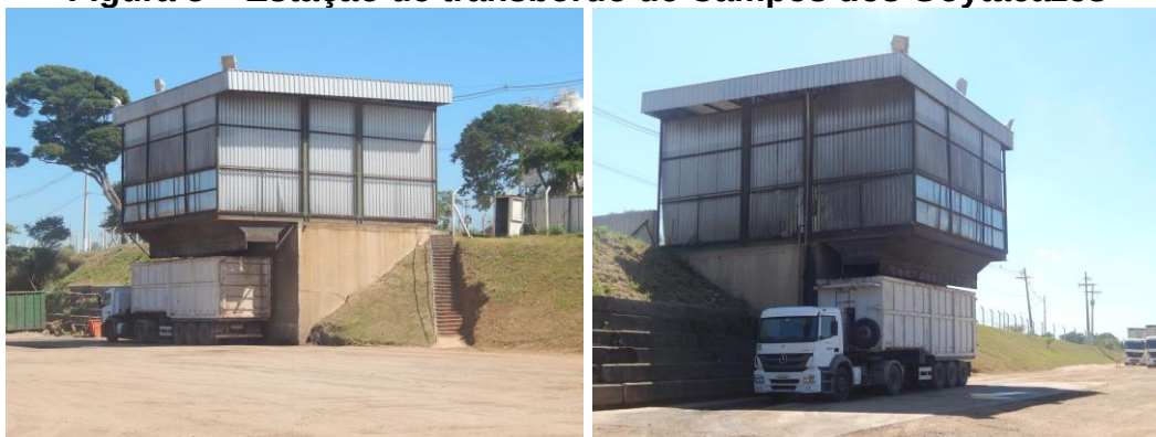
Figura 5 – Estação de transbordo de Campos dos Goytacazes
